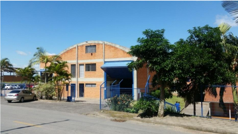
Figura 53 - Foto da Servitech situada em Tubarão/SC praticamente às margens da Rodovia BR-101
