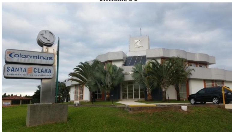
Figura 48 - Foto da matriz da Colorminas localizada polo cerâmico de Criciúma/SC
