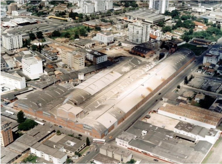
Figura 1 - CESACA instalada no centro urbano de Criciúma/SC.
