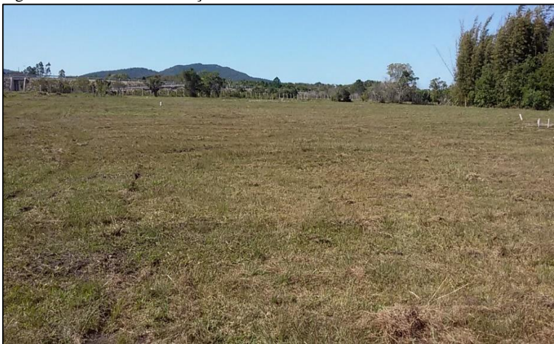
Figura 12 – Local de instalação das malhas de aterramento
