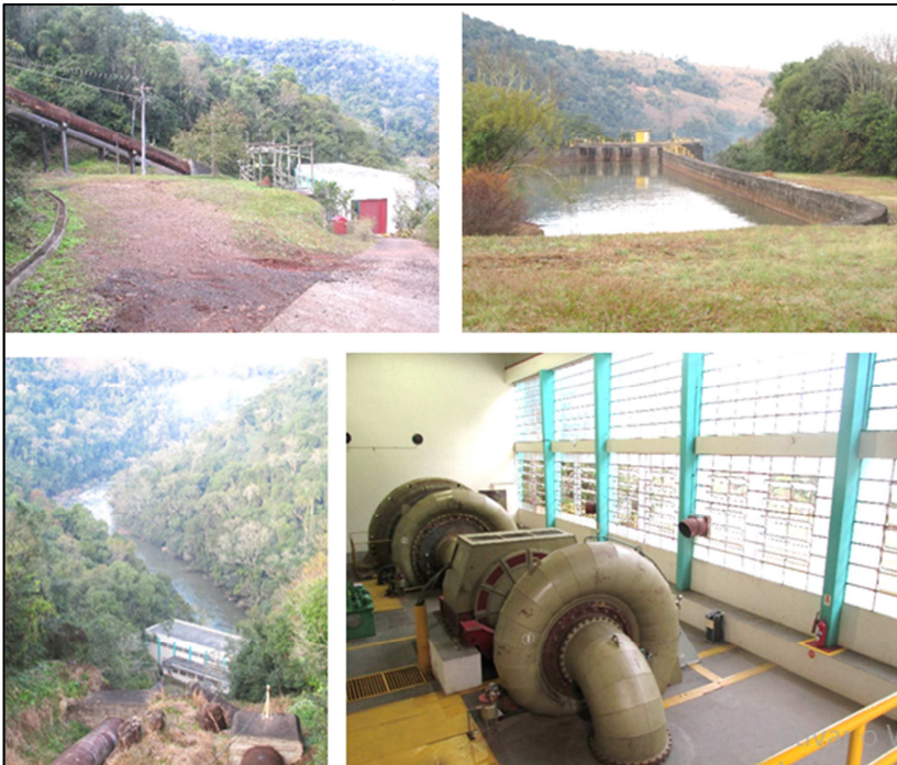
Figura 28 — Salto Voltão em sua casa de força, condutos, tomada d'água, turbinas
