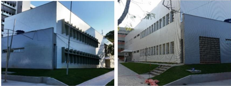
Figura 9 – Perspectiva do edifício CFH.
