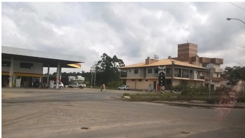
Figura 7 - Passagem de nível no município de Morro da Fumaça/SC
