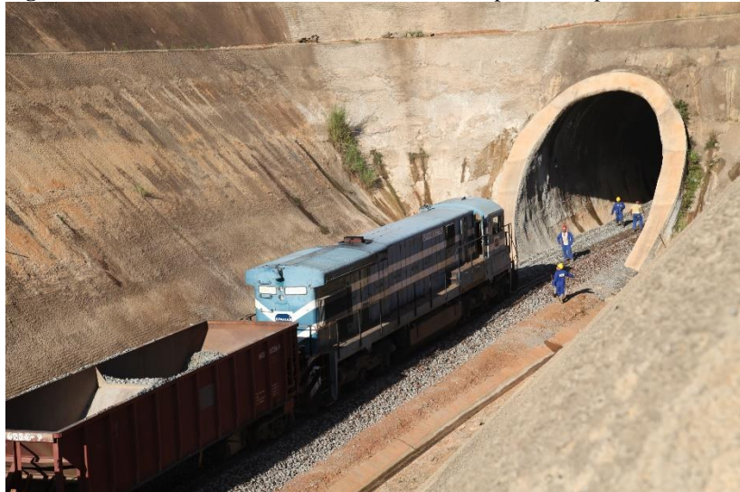
Figura 13 - Túnel 2 da Ferrovia Norte-Sul no município de Anápolis/GO, 2014
