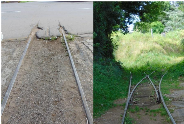
Figura 6 - Trecho ferroviário na área central da cidade de Bento Gonçalves/SC, 2016
