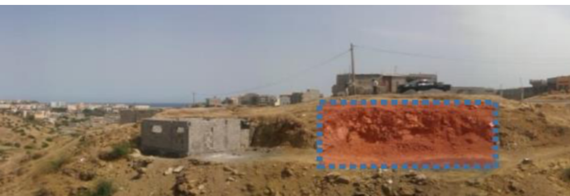
Figura 61 - Encosta Varzea Acima (2014) | Fonte: CORREIA, 2015, pág 39
