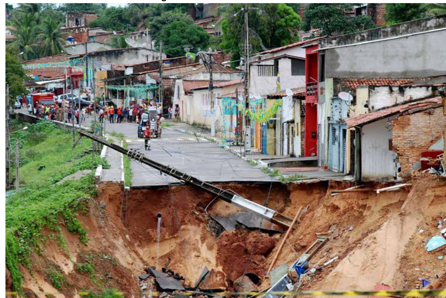
Imagem 2: Deslizamento da cidade de Natal
