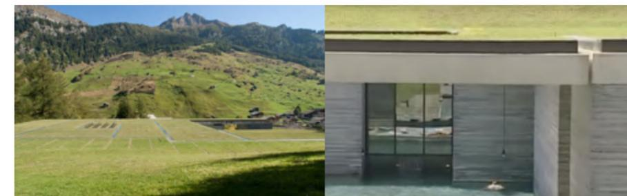
Figura 17: Cobertura verde com espaçamentos entre as lajes para passagem de luz. Fonte: The Thermae of Stone<sup>4</sup>.
