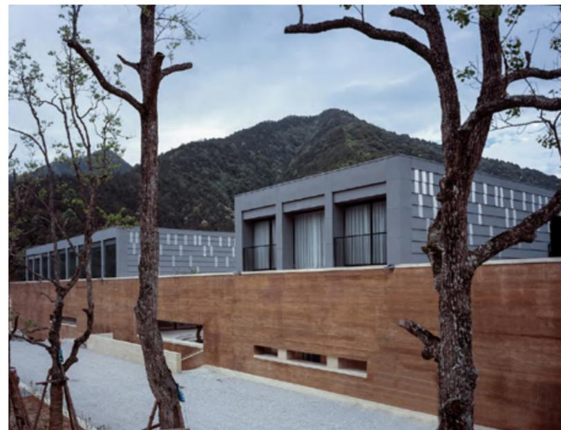
Figura 36: Vista lateral do edifício com as paredes em taipa de pilão. Fonte: Archdaily<sup>24</sup>.
