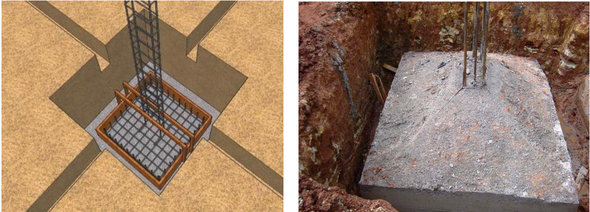
Figura 41 – Fotos de sapatas isoladas
