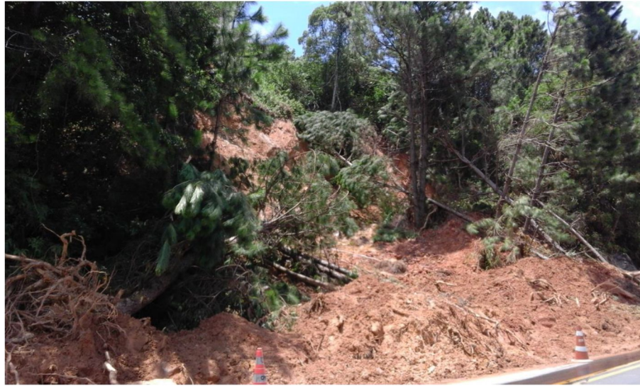
Figura 21: Vista frontal do deslizamento SC-406.
