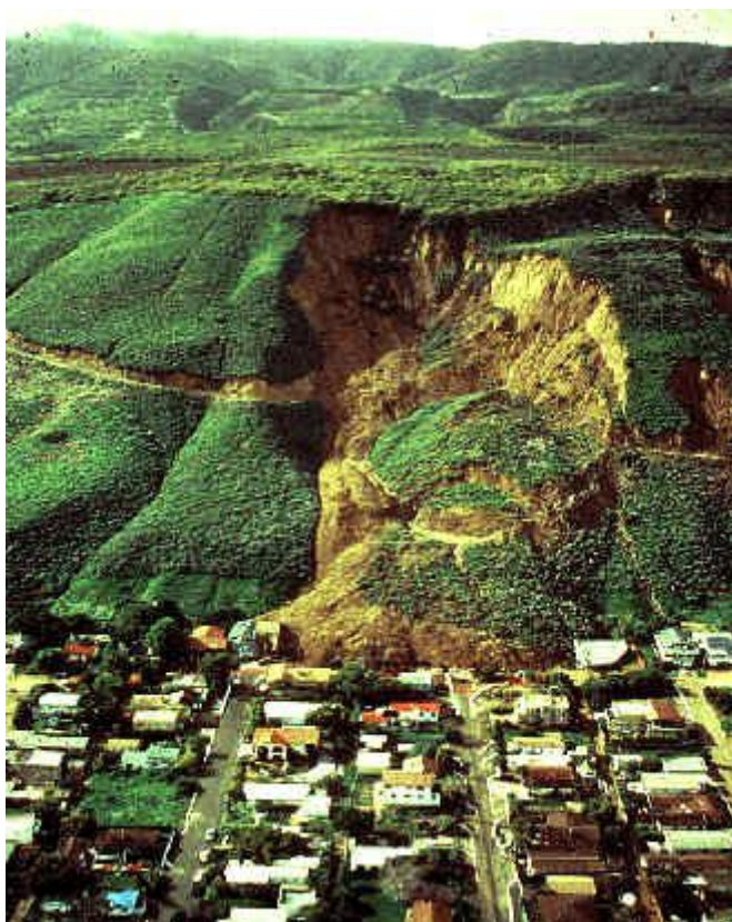
Figura 9: Deslizamento circular ocorrido em 1995, em La Conchita, Califórnia, Estados Unidos da América.
