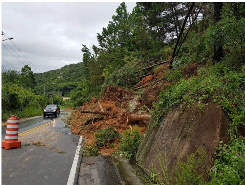
Fonte: Laudo Geológico de Urgência Defesa Civil, 2018.
