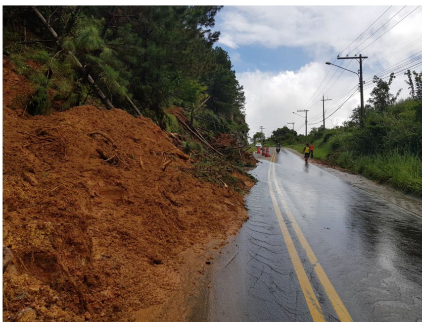
Fonte: Laudo Geológico de Urgência Defesa Civil, 2018.
