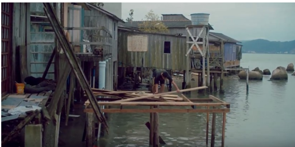
Figura 4 - Construção de palafitas na Ponta do Leal. 2019. Fonte: Tomás Tancredi.
