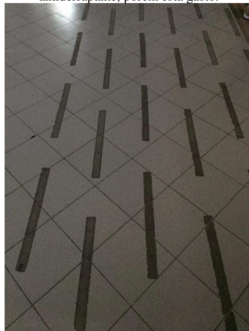
Figura 41 – Há revestimento com material antiderrapante, porém está gasto.
