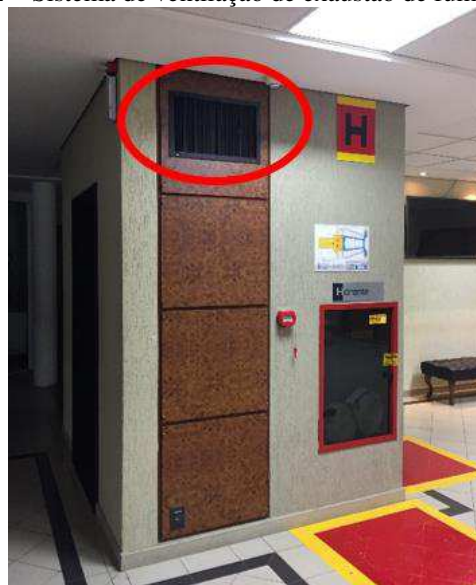
Figura 52 – Sistema de ventilação de exaustão de fumaça e calor
