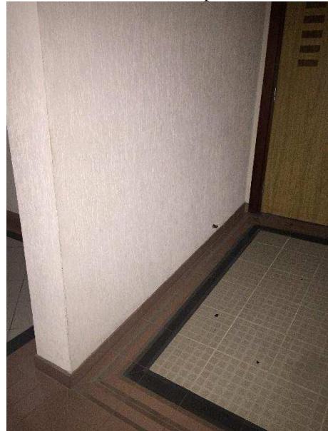
Figura 33 - Abertura das folhas de portas sobre a rampa
