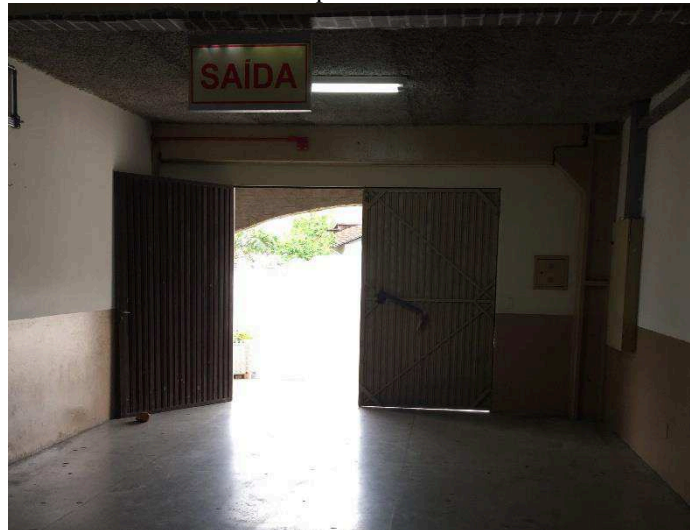
Figura 79 – Sentido da abertura da porta está ao contrário do trânsito de saída
