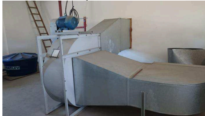
Figura 53 – Duto do sistema de ventilação de exaustão com motor acionado manualmente
