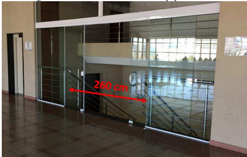
Figura 51 – Escada central de acesso ao Espaço Panorâmico
