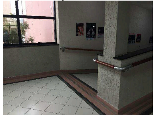
Figura 46 – Rampa sem corrimão contínuo
