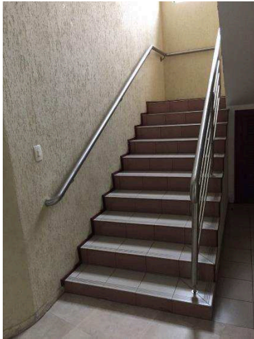
Figura 30 – Escada sem prolongamento do corrimão de no mínimo 30 cm
