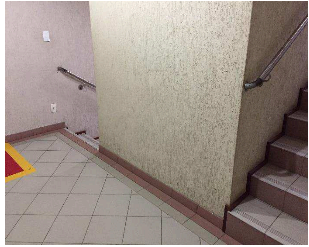
Figura 31 – Escada sem corrimão contínuo em ambos os lados
