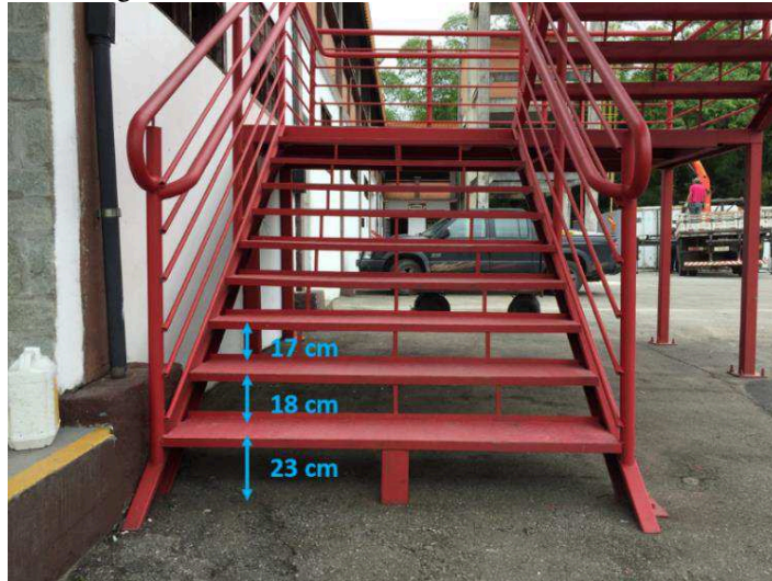
Figura 77 – Escada com elementos fora das normas
