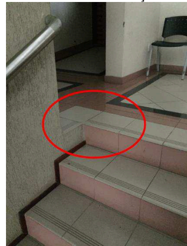
Figura 29 – Degrau da escada invadindo a circulação
