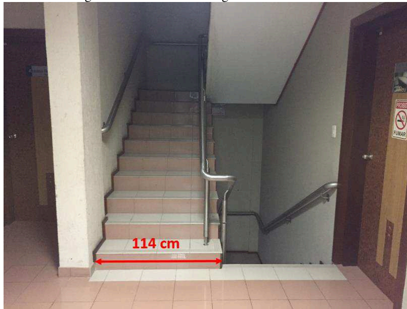
Figura 50 – Escada com largura inferior a 150 cm
