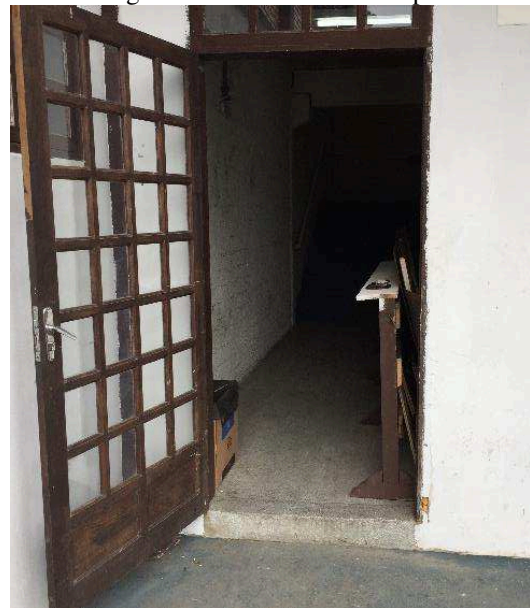
Figura 76 – Ausência de rampa
