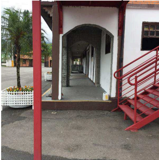
Figura 81 – Ausência de rampa
