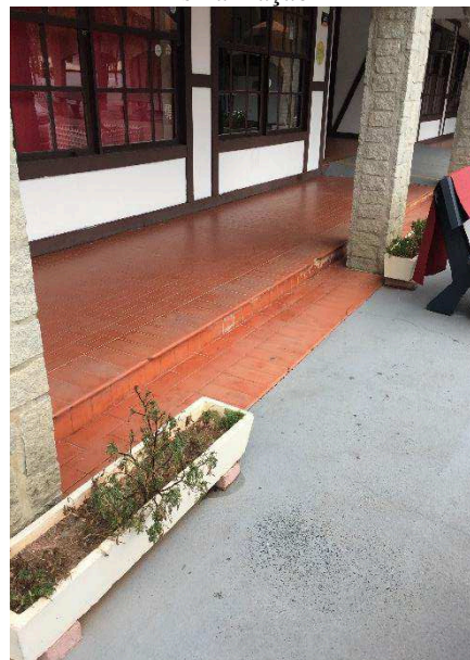
Figura 84 – Degraus sozinhos sem marcação e sinalização
