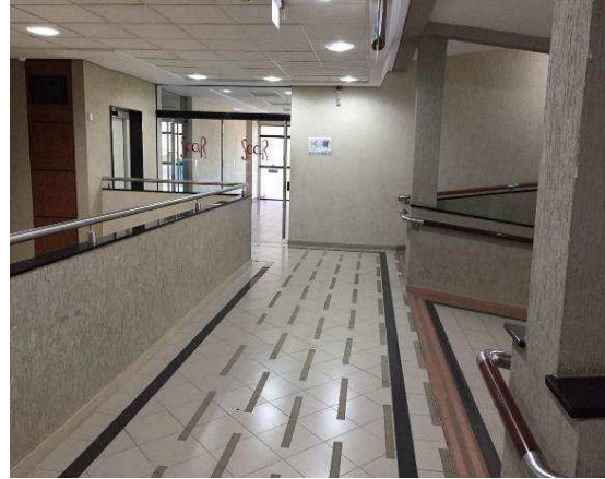
Figura 35 – Sem sinalização tátil
