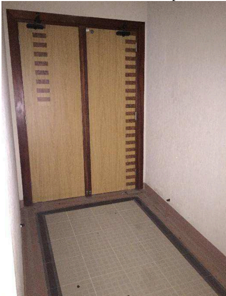
Figura 32 - Abertura das folhas de portas diretamente sobre as rampas
