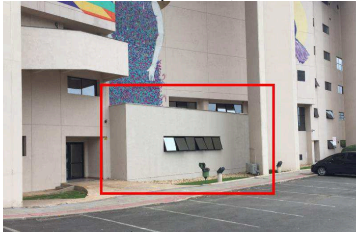
Figura 26 – Ampliação realizada em 2018 (vista parte externa)
