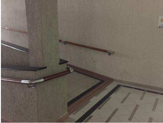
Figura 34 – Rampa sem prolongamento do corrimão de no mínimo 30 cm
