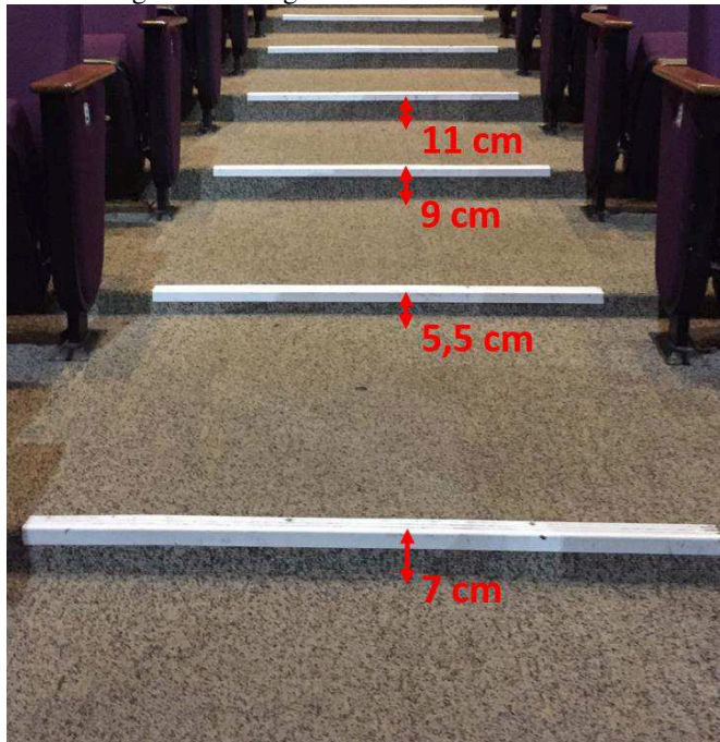
Figura 61 – Degraus com diferentes alturas
