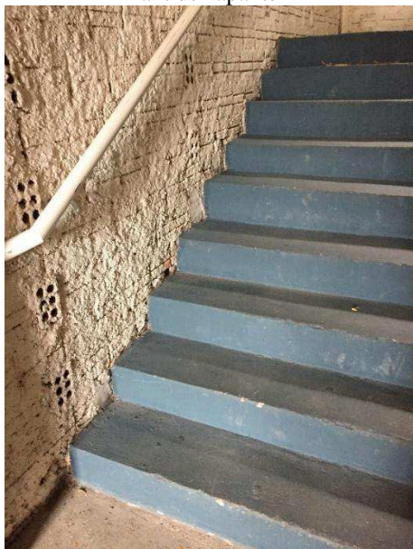
Figura 83 – Escada sem revestimento antiderrapante
