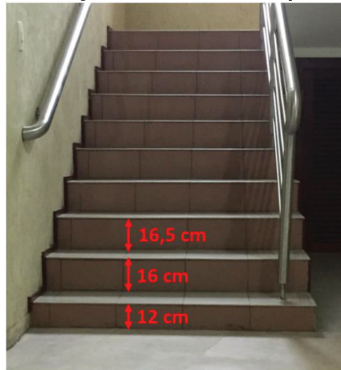
Figura 47 – Escada com espelho incorreto e com variação nas alturas
