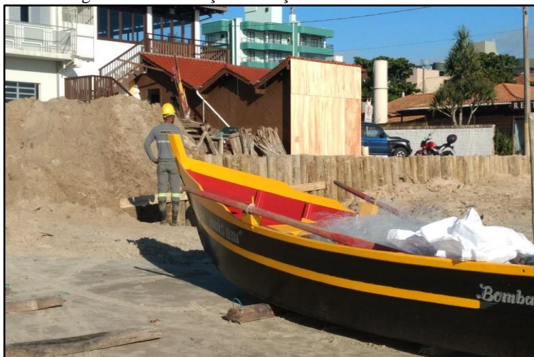
Figura 21 - Construção do calçadão da Praia de Bombas.
