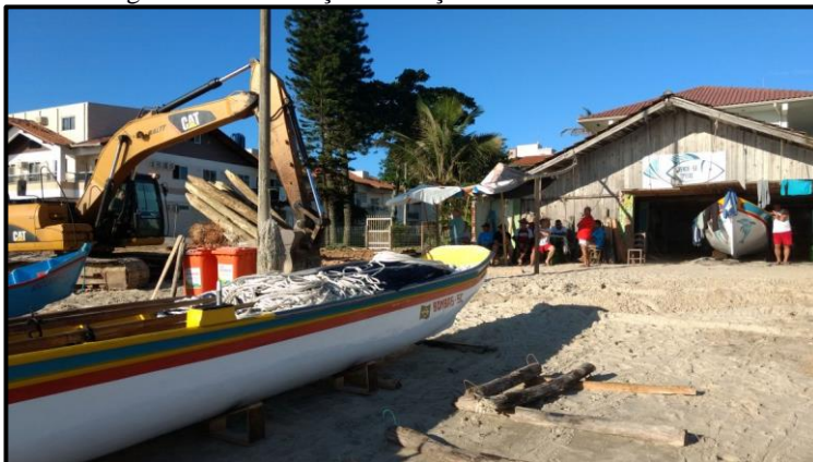
Figura 20 - Construção do calçadão da Praia de Bombas
