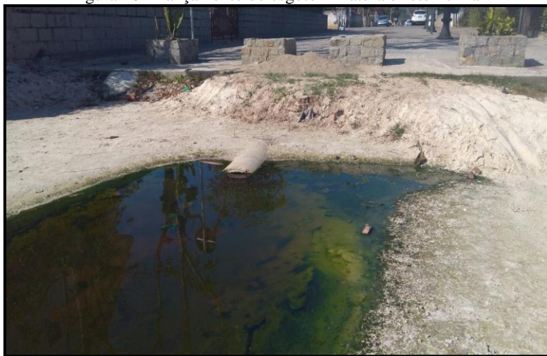
Figura 16 - Lançamento do esgoto in natura direto no mar
