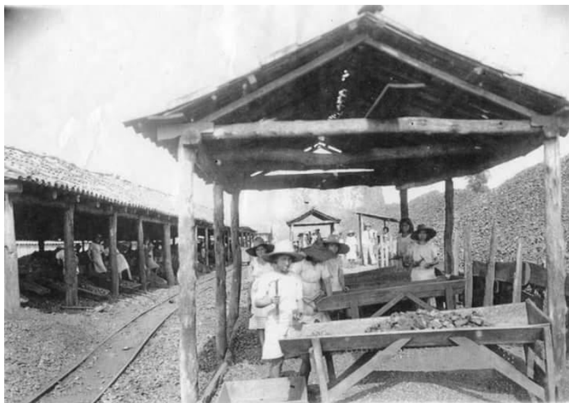
O barracão onde era feita a escolha possuía uma mesa na qual o peneirador deveria colocar as pedras de carvão. Mina Hercílio Luz, Criciúma, 1938-1939. Fonte: CEDOC/UNESC.
