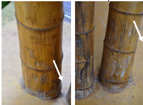
Figura 132 – Rachaduras nos extremos dos colmos preenchidos com concreto.
