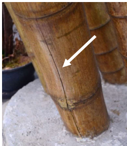
Figura 58 - Rachadura no extremo concretado de colmo.
