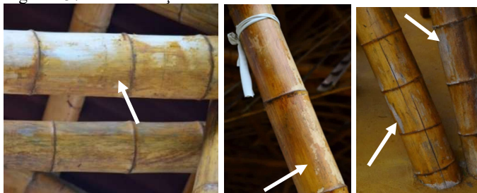
Figura 137 - Deterioração do verniz nos colmos.
