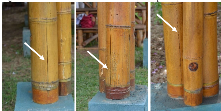
Figura 82 - Rachaduras nos extremos dos colmos preenchidos com concreto.
