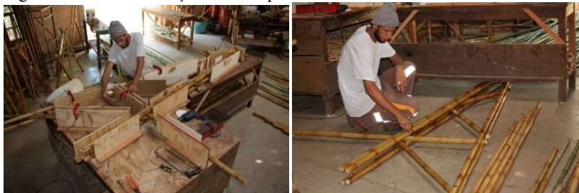
Figura 116 - Pré-fabricação dos componentes estruturais.
