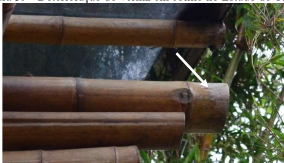
Figura 59 - Deterioração do verniz em colmo no Estudo de Caso 2.
