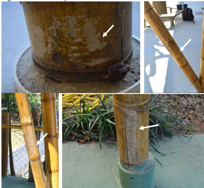
Figura 46 - Deterioração do verniz nos colmos no Estudo de Caso 1.
