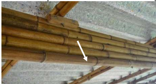
Figura 121 - Rachadura na parte central do colmo inferior das vigas.
