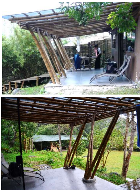
Figura 54 - Estrutura de bambu no Estudo de caso 2.
