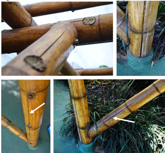
Figura 40 - Rachaduras nos extremos dos colmos preenchidos com concreto.
