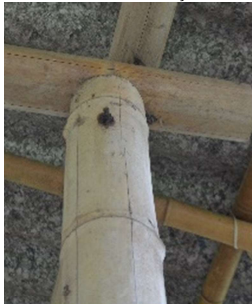
Figura 109 - Descoloração de colmo.
