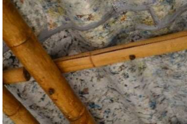
Figura 151 - Esmagamento de ripa de bambu.
