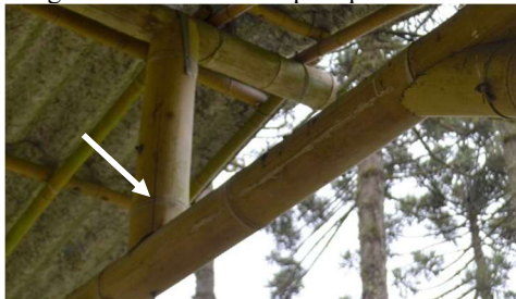
Figura 106 - Rachadura por apoio incorreto.
