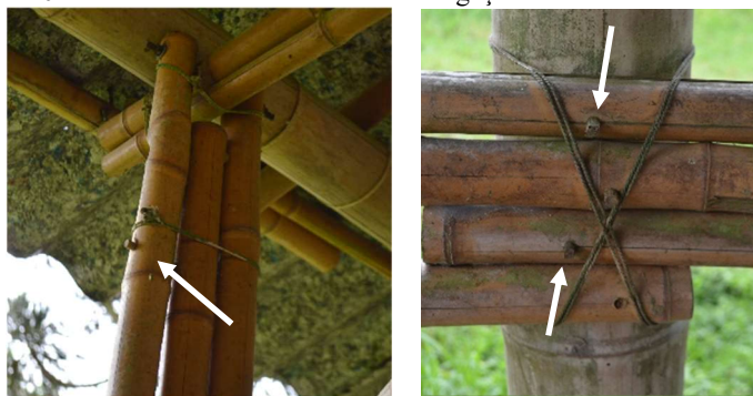
Figura 102 - Uso de cavilhas de bambu nas ligações.
