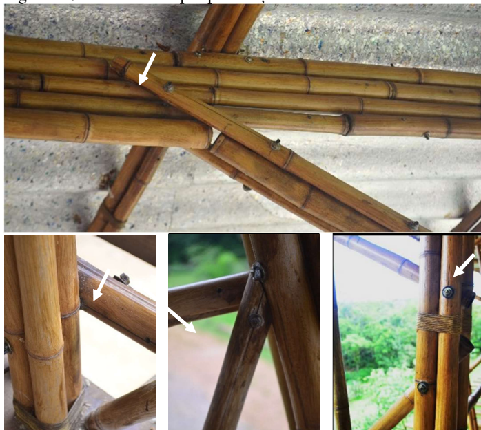
Figura 119 - Rachaduras por penetração.
