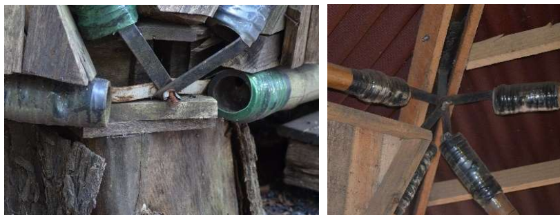
Figura 66 - Conexões utilizadas para os elementos de bambu na estrutura B do Estudo de Caso 3.
