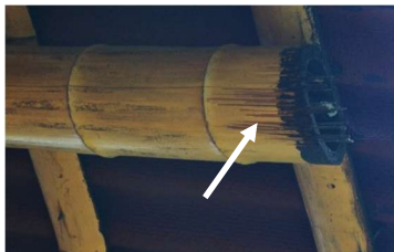
Figura 135 - Lascas nos extremos dos colmos.
