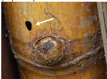
Figura 51 - Perfuração pelo ataque do C. annularis .
