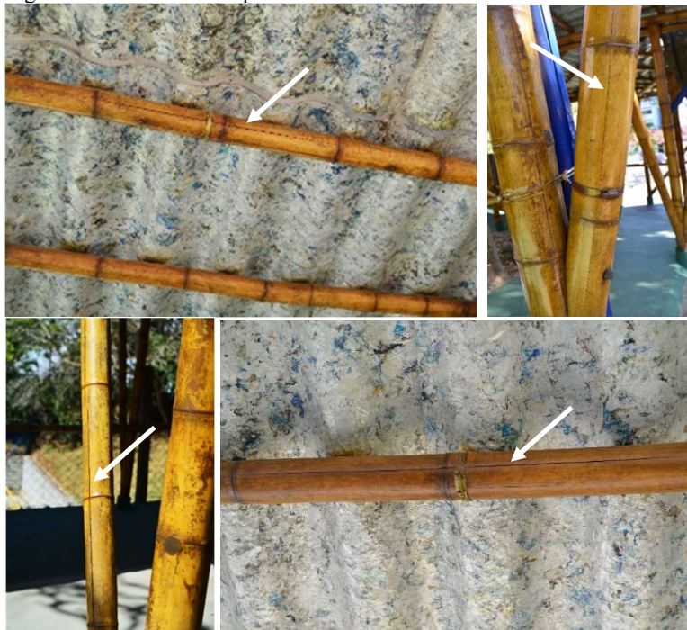
Figura 41 - Rachadura na parte central dos colmos.
