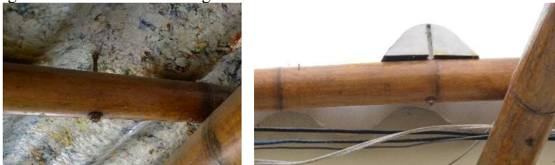
Figura 34 - Detalhe de ancoragem das coberturas aos caibros de bambu.
