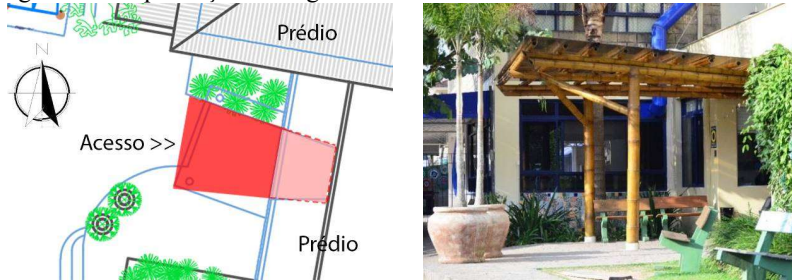
Figura 29 - Implantação e fotografia da estrutura A do estudo de caso 1.
