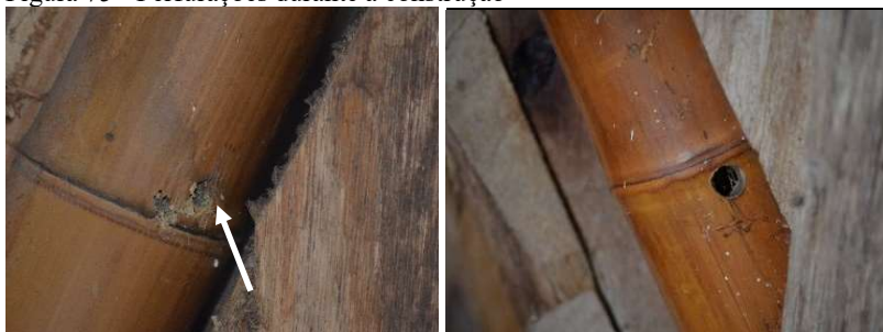
Figura 75 - Perfurações durante a construção
