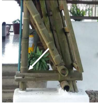
Figura 145 - Conexão estrutural em obra projetada por Simón Vélez em 1988.
