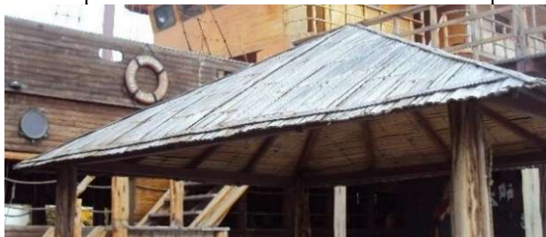
Figura 12 - Aparência de cobertura de esteira de bambu exposta ao sol.
