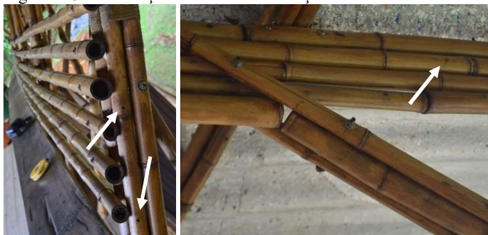
Figura 125 - Perfurações durante a construção e fase de uso.
