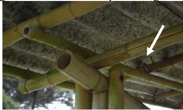
Figura 105 - Rachadura por esmagamento.
