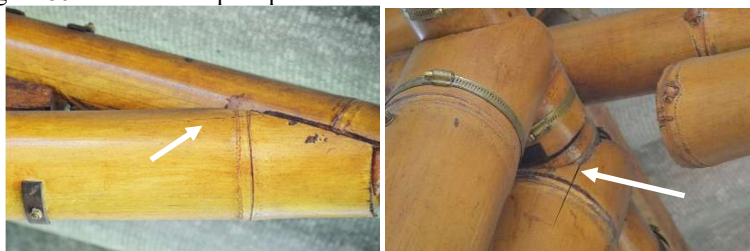
Figura 86 - Rachaduras por apoio incorreto
