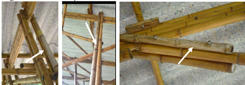
Figura 122 - Deterioração do verniz nos colmos.
