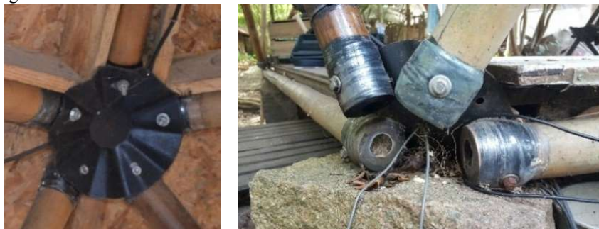
Figura 65 - Elemento metálico de conexão dos colmos de bambu na estrutura A
