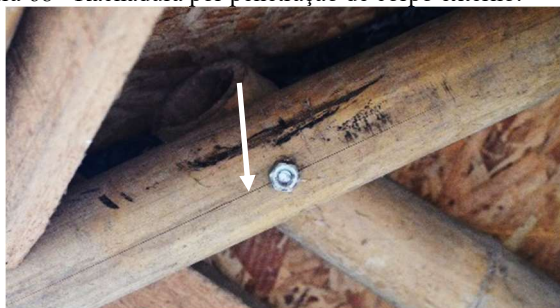
Figura 68 - Rachadura por penetração de corpo externo.
