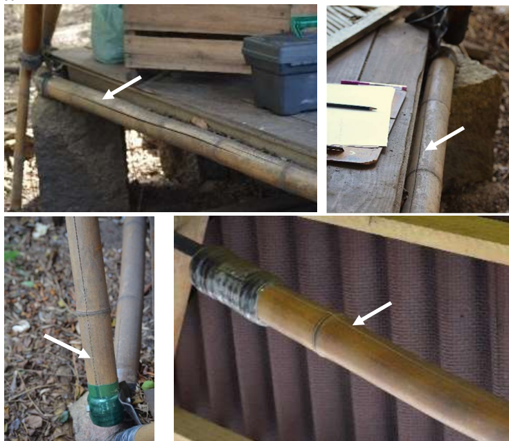
Figura 69 - Rachadura nos extremos dos colmos.
