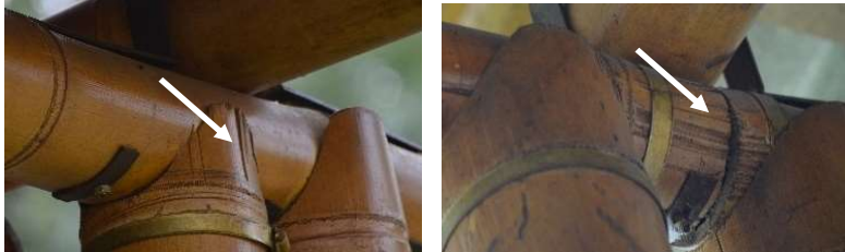
Figura 83 - Lasclas nos extremos dos colmos.
