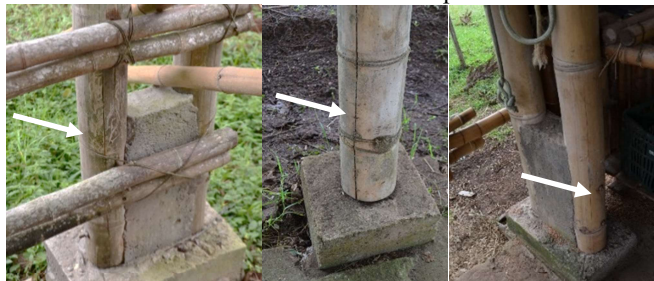
Figura 104 - Rachaduras nos extremos dos colmos preenchidos com concreto.
