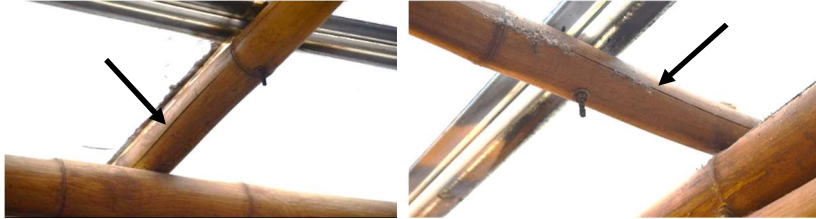
Figura 57 - Rachaduras por esmagamento no estudo de caso 2.
