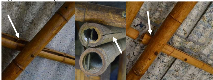
Figura 53 - Esmagamento dos colmos nas estruturas do Estudo de Caso 1.
