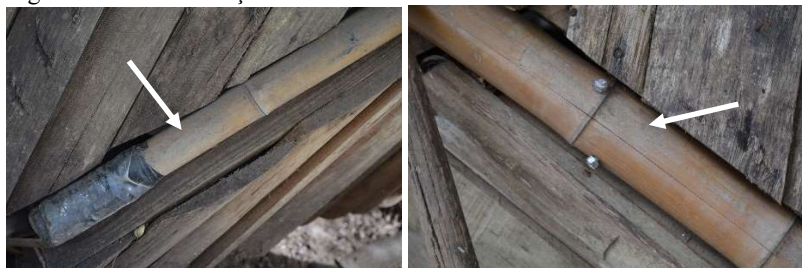
Figura 71 - Descoloração do colmo.
