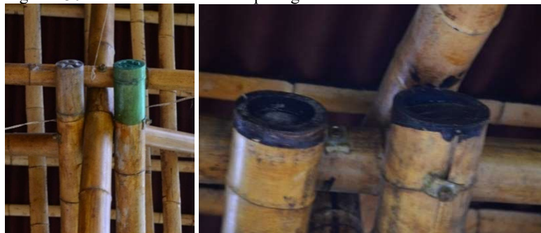
Figura 130 - Extremos dos colmos protegidos.
