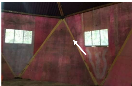
Figura 67 - Espuma de poliuretano cobrindo os elementos de bambu das paredes ao interior da estrutura C.
