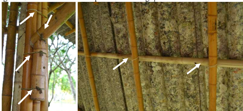
Figura 101 - Uso de cordão de poliamida nas ligações.
