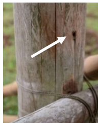
Figura 110 - Perfurações deixadas durante a construção e na fase de uso.
