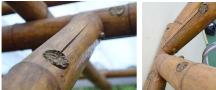
Figura 144 - Rachaduras nos entrenós concretados.
