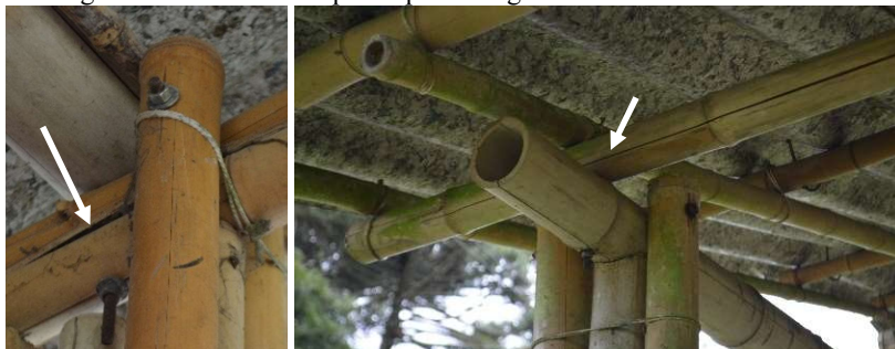
Figura 112 - Colmo colapsado por esmagamento.
