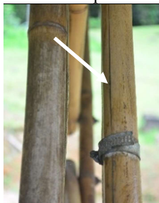
Figura 120 - Rachaduras na parte central dos colmos.
