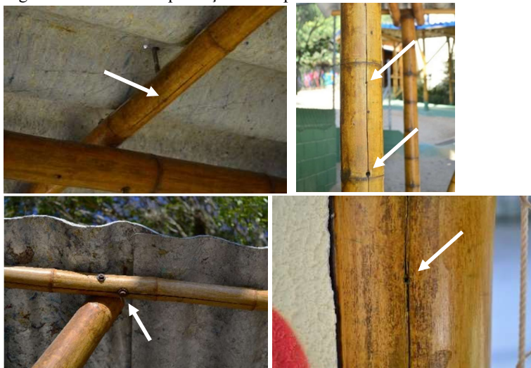
Figura 42 - Rachadura pela ação de corpo externo.
