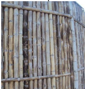
Figura 11 - Efeitos das intempéries em cerca de bambu.
