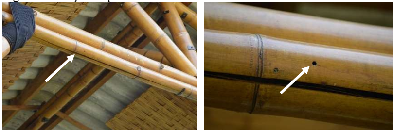
Figura 94 - Peça colapsada no Estudo de Caso 4.
