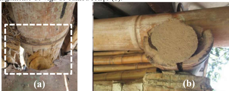
Figura 18 - Degradação do bambu de colunas por xilófagos (a) e ruptura por esmagamento de viga de bambu roliço (b).
