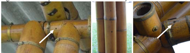
Figura 90 - Perfurações deixadas durante a construção e na fase de uso.
