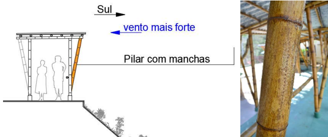
Figura 150 - Pilares com mais ocorrências de manchas verdes e pretas.
