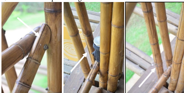
Figura 118 - Rachaduras por esmagamento nos colmos.
