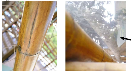
Figura 43 - Rachaduras durante a secagem
