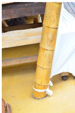
Figura 129 - Detalhe das fundações no Estudo de Caso 7.
