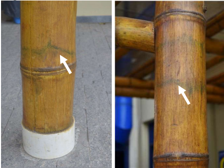
Figura 44 - Manchas verde azuladas em estruturas do Estudo de Caso 1.
