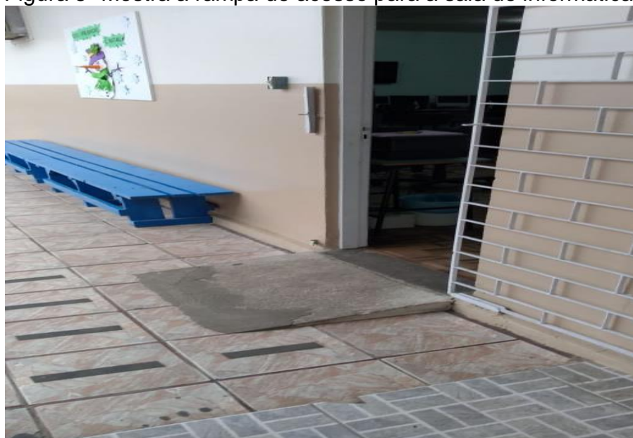
Figura 5- Mostra a rampa de acesso para a sala de informática.
