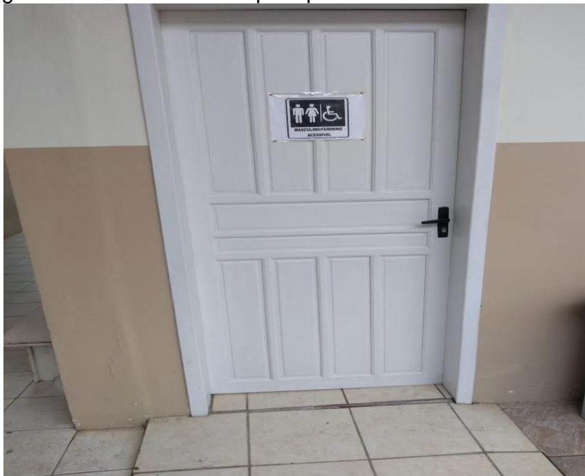
Figura 7-Mostra o banheiro para pessoas com deficiência física.
