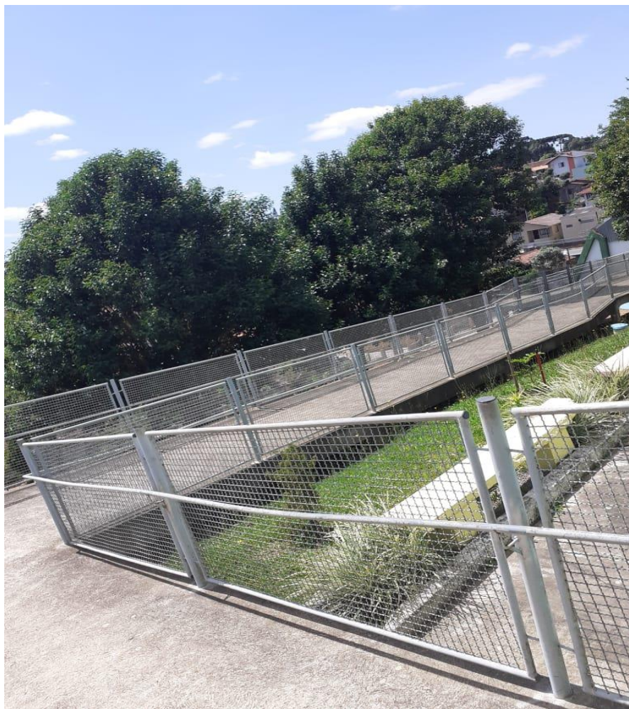
Figura 05: Rampa que dá acesso ao ginásio da escola.
