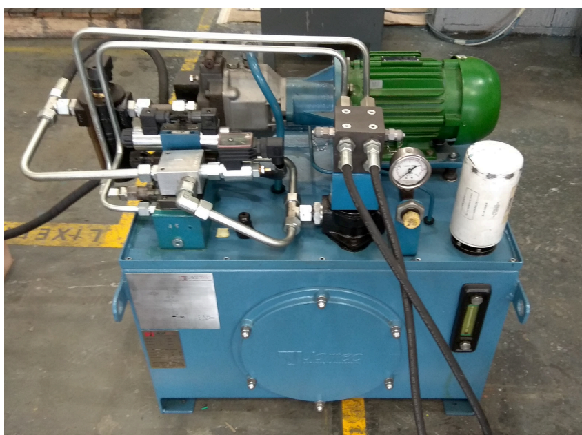
Figura 21 – Unidade hidráulica utilizada.
