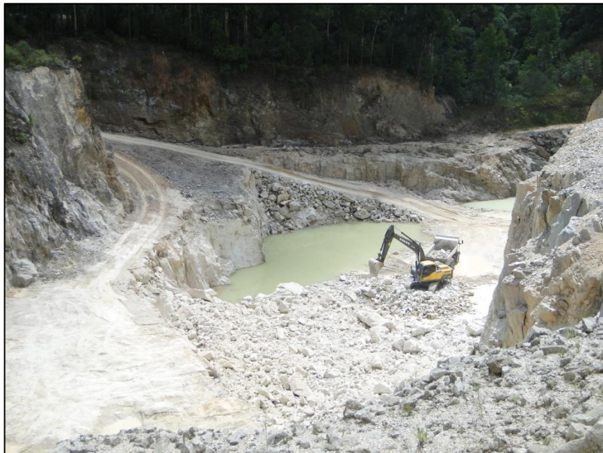
Figura 2. Visão panorâmica do pátio de lavra, sentido de vista oeste. A extração mineral é realizada por desmonte mecânico, devido ao alto grau de desagregação do material.
