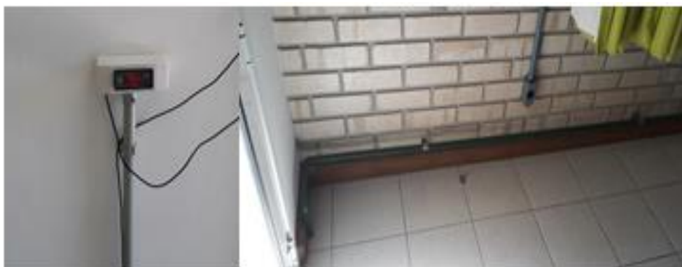
Figura 16: Sistema de aquecimento solar 24 .
