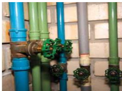
Figura 9: Encanamento com cores distintas 15 .
