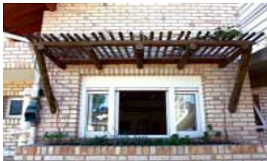
Figura 18: Janela da cozinha, fachada oeste 26 .
