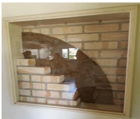
Figura 11: Parede externa da casa 17 .
