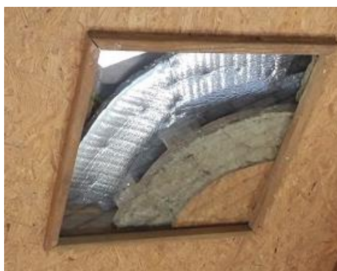
Figura 12: Telhado da casa 19 .
