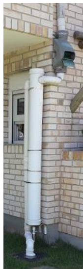
Figura 7: Sistema de coleta da água da chuva 13 .
