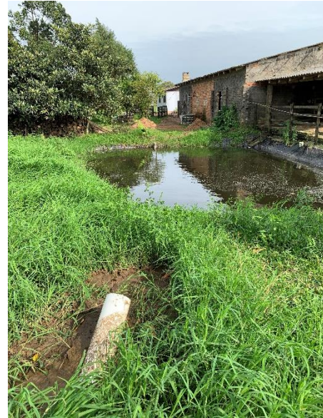
Figura 8 – Caixa saída biodigestor.
