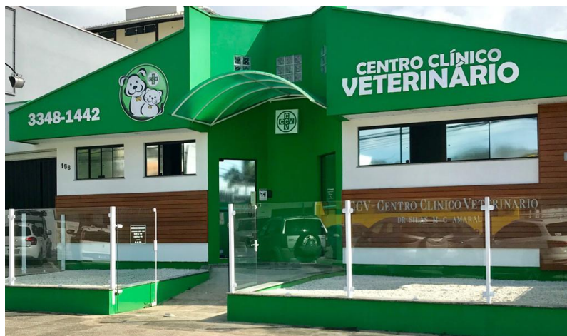
FIGURA 1 - Centro Clínico Veterinário. Fachada da Clínica.
