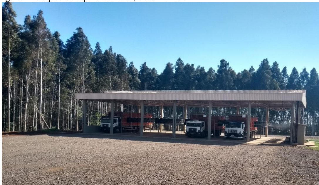
Figura 1- Galpão de espera das aves, vista frontal.
