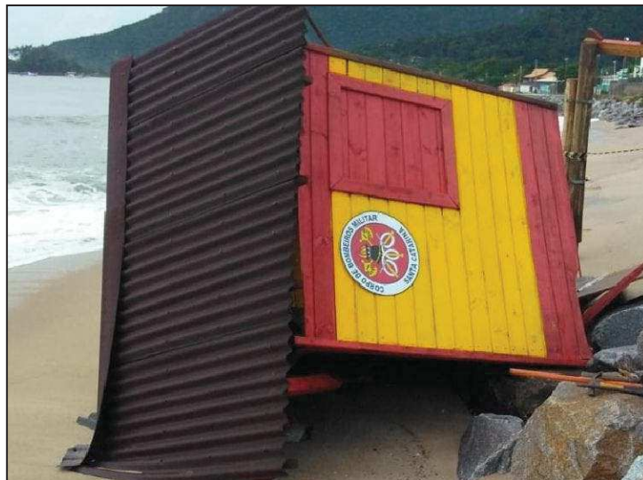
Figura 2 – PGV tombado devido a intempéries.
