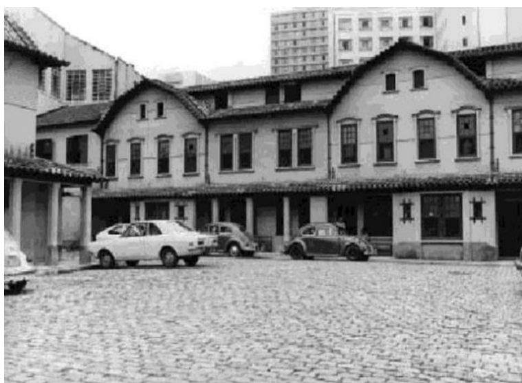
Figura 7 – Vila Marquesa de Itu ou Vila Inglesa.
