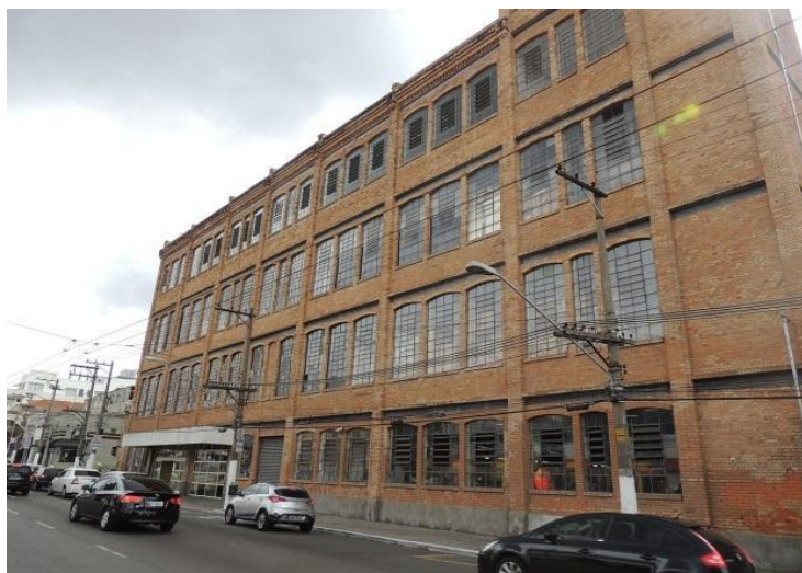
Face leste do prédio do Cotonifício Rodolfo Crespi, em São Paulo (SP). Foto: Enrico Liberatori
