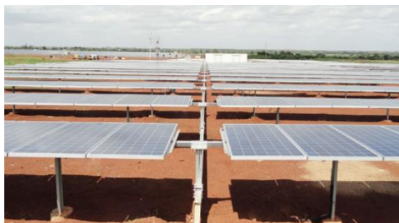
Figura 17 - Rastreador na configuração 1V
