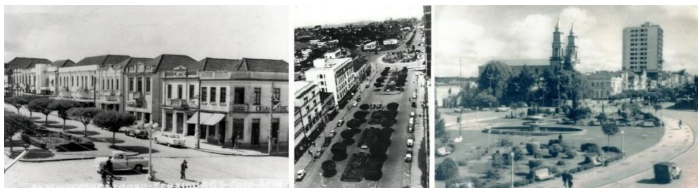
Figura 12: Centro de Erechim em 1950 (esquerda), 1955 (centro) e 1958 (direita). Destaque para a mudança dos gabaritos dos edifícios centrais. Fonte: (Jornal Boa Vista, 2016)
