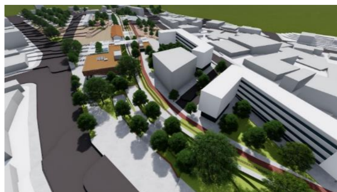
Figura 53: Vista geral dos blocos da moradia (fachada Sul) e a sua relação com o prédio da UFFS.
