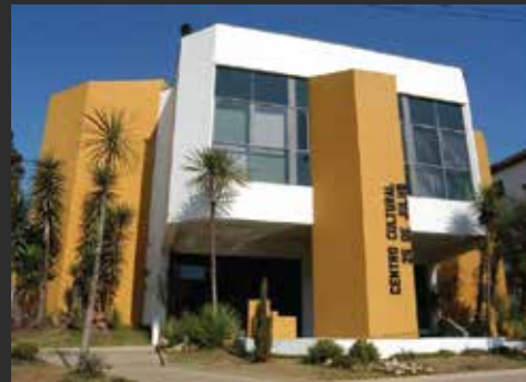
5 Centro Cultural 25 de Julho Fonte: PM de Erechim
