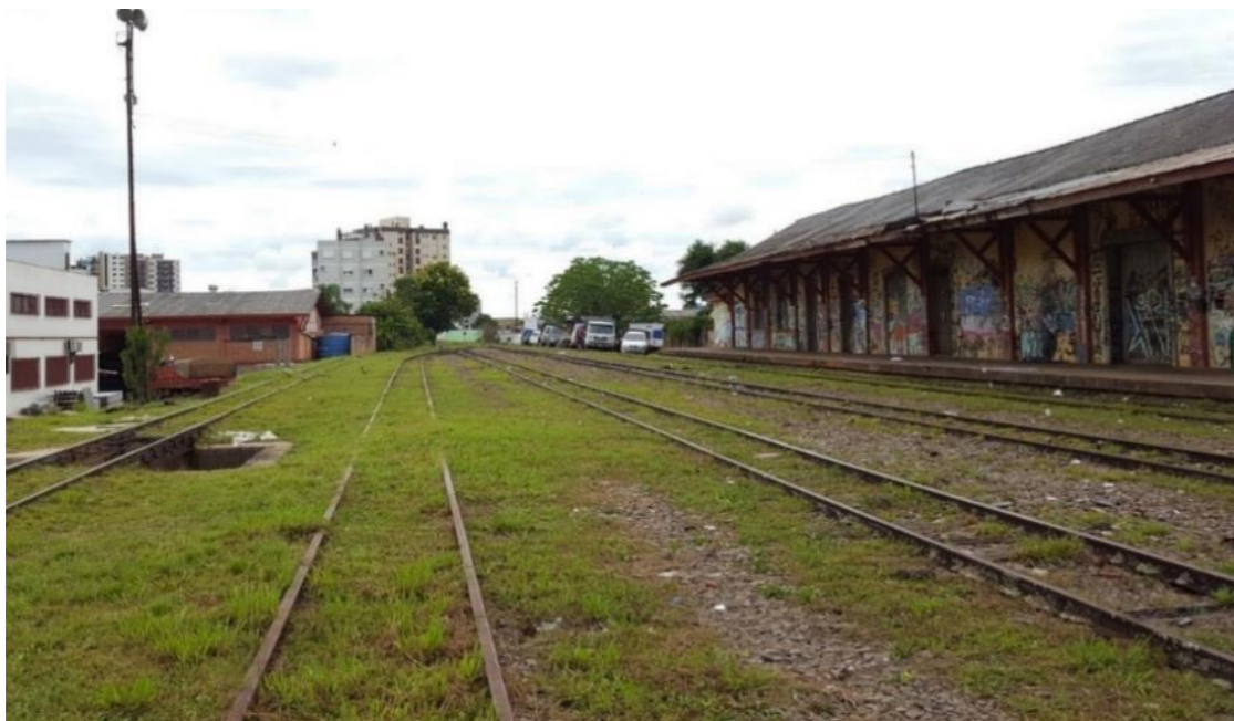
Figura 1: Edificação da antiga Estação Ferroviária de Erechim, hoje muito degradada. Fonte: Acervo Pessoal (2016).
