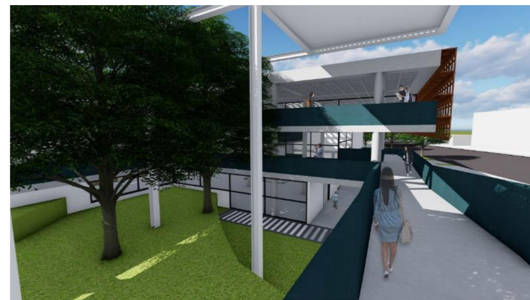
Figura 77: Vista da fachada oeste, a partir da rampa. Destaque para os três pavimentos da edificação (e sua estrutura), cobertura metálica, brise e ventilação do subsolo.
