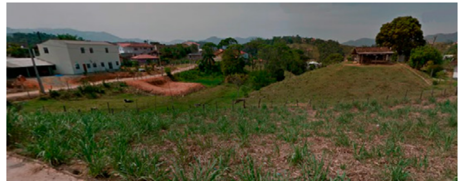
Vista do terreno a partir da Rua Emanuel Emílio Campos
