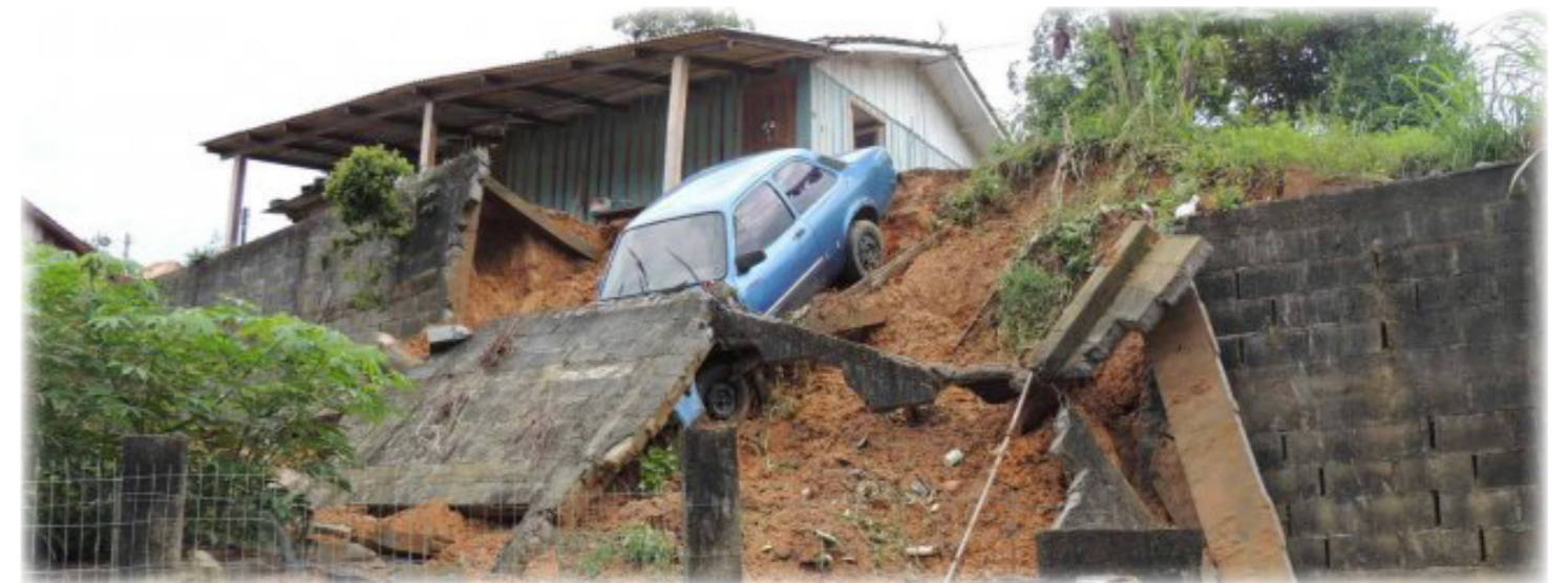
Consequências das enchentes em áreas de risco por deslizamentos de terra
