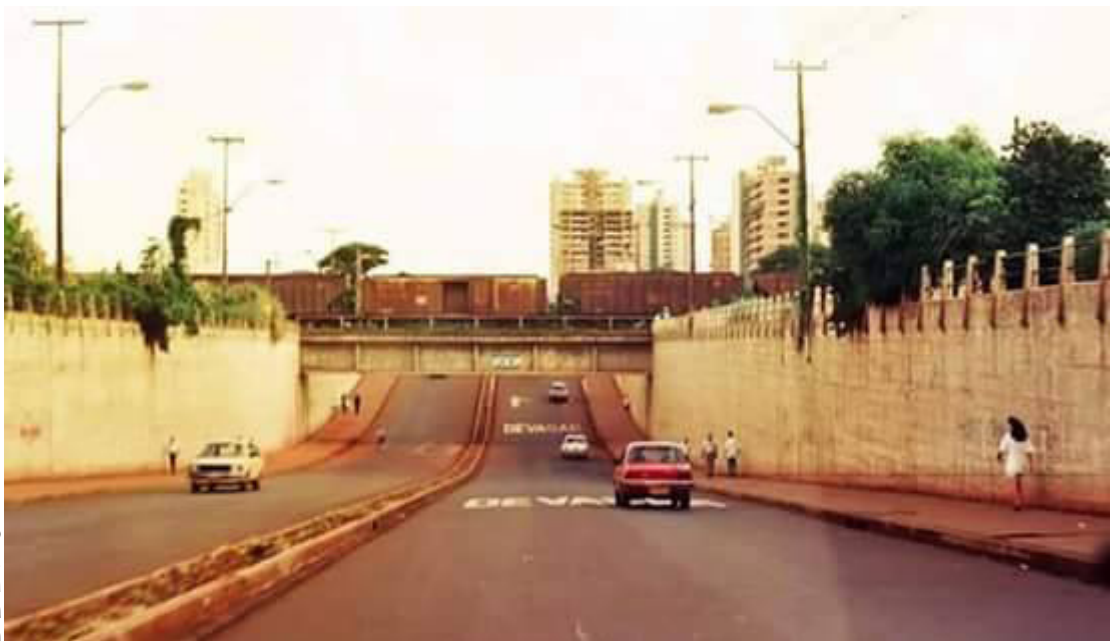
Figura 09: Viaduto do café. Sem data Fonte: Maringá Memória
