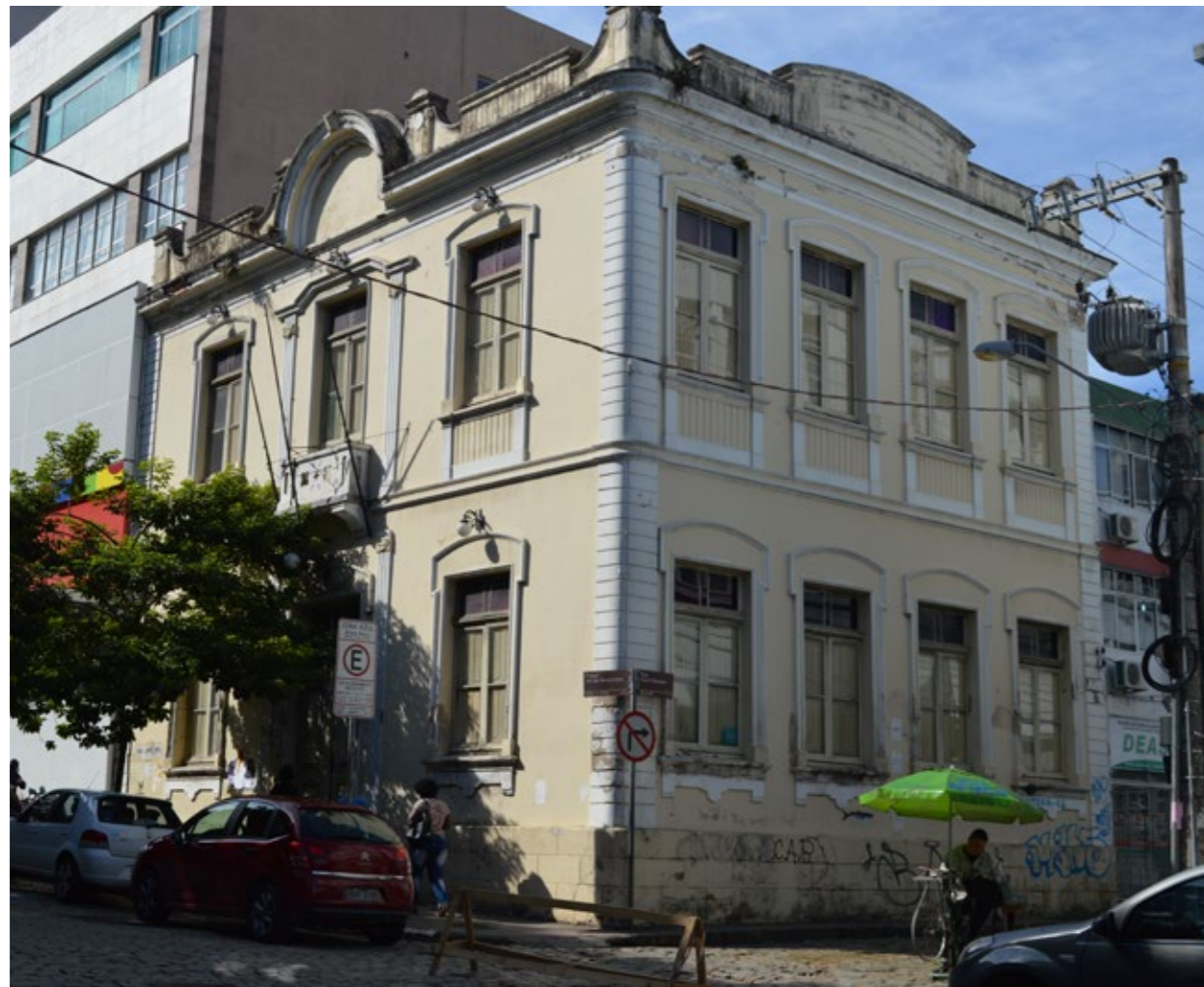
Edifício Histórico Abandonado FONTE: AMA/Projeto Arco Iris
