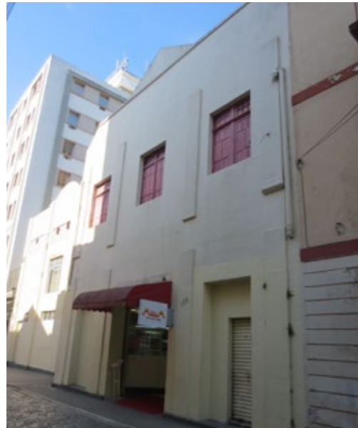
Edifício Atual com a Milium ainda em funcionamento FONTE: Acervo Pessoal
