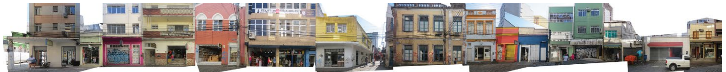
Fachada Norte Calçadão João Pinto FONTE: Acervo Pessoal
