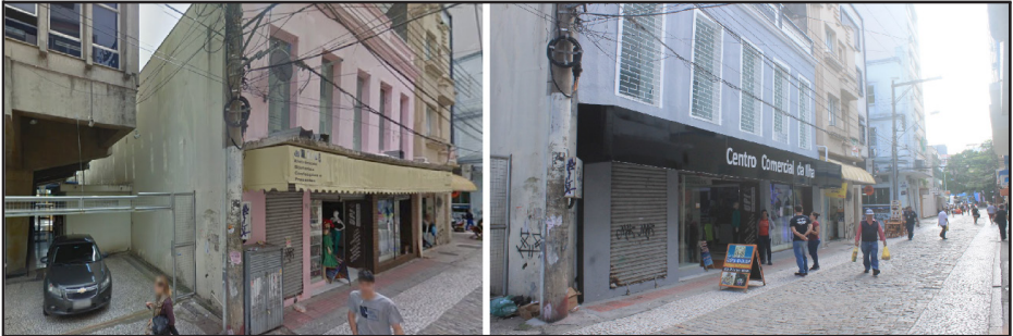
Figura 16 - Centro Comercial da Ilha antes e depois da reforma. Fotos retiradas do google.maps e de autoria de Bernardo Rocha, respectivamente.
