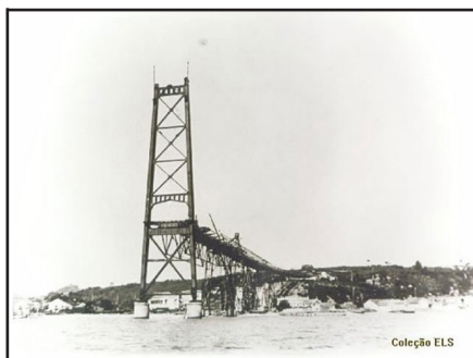
Figura 8 - Início da construção da ponte Hercílio Luz. Foto: Coleção ELS. Disponível em: < http://nossahercilioluz.com.br/as-tres-irmas-saiba-mais-sobre-as-pontes-de-florianopolis >
