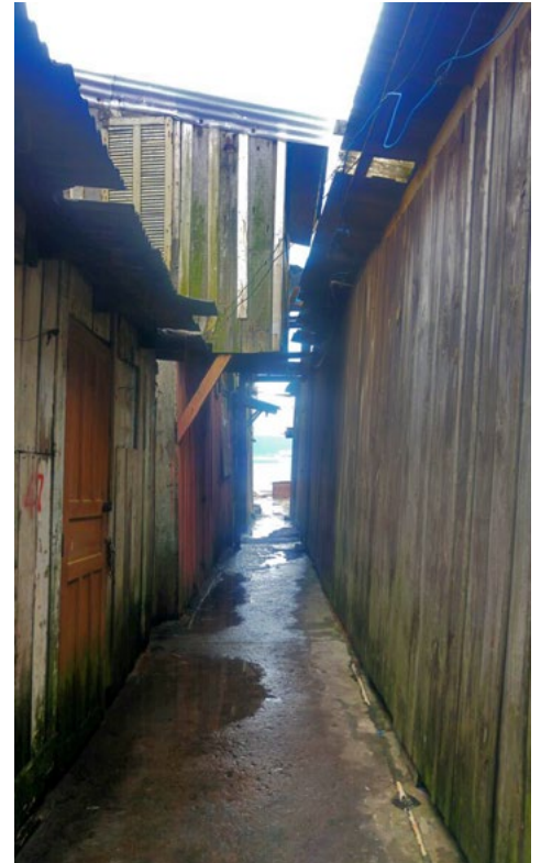
Corredor entre as casas Fonte: ACERVO PESSOAL
