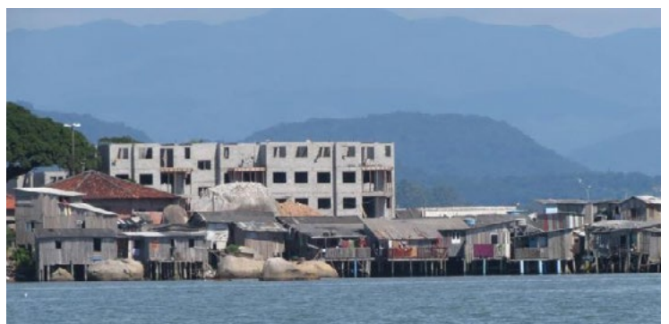
Nova edificação atrás das palafitas
