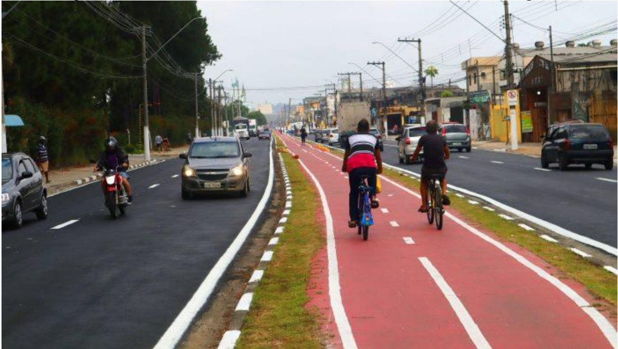
Figura 17 – Ciclovia de Suzano, na Avenida Vereador João Batista Fittipaldi
