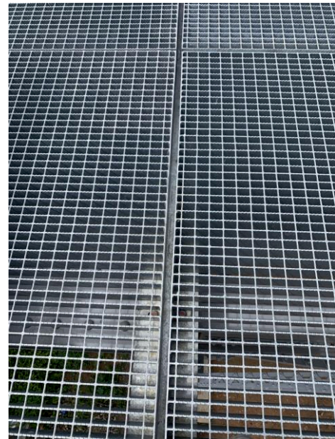
Figura 33 – Gradis justapostos com a presença da junta simples de dilatação.
