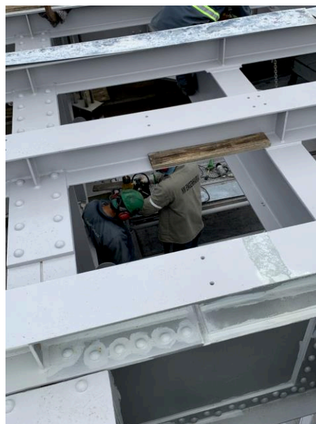
Figura 61 - Furação da chapa galvanizada.
