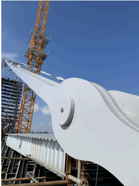
Figura 19 – Barras de olhal instaladas na Ponte Hercílio Luz
