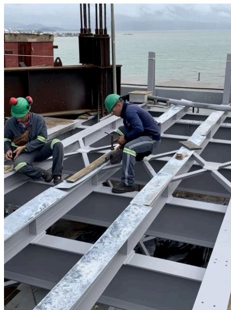
Figura 59 - Colocação das chapas galvanizadas na posição correta e marcação dos furos na chapa.
