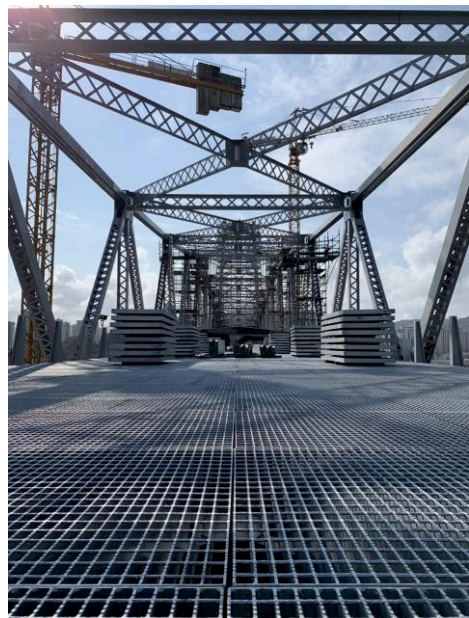
Figura 47 - Gradis armazenados na ponte para instalação.
