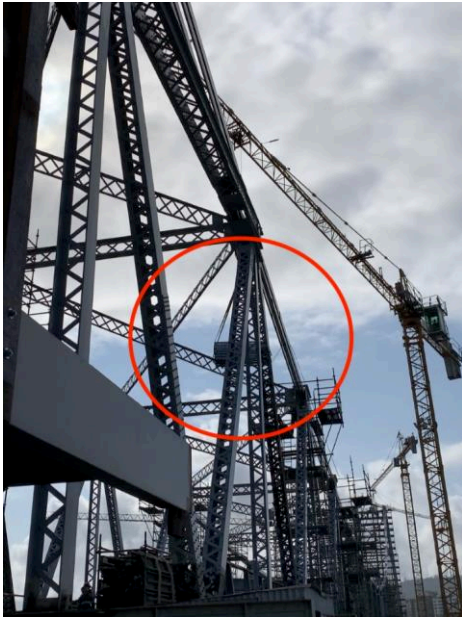
Figura 41 – Transporte de gradis passando pela treliça do vão central.
