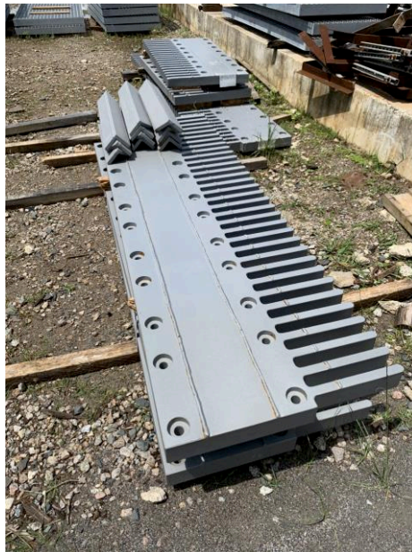
Figura 34 – Juntas de dilatação entre o vão central e os viadutos
