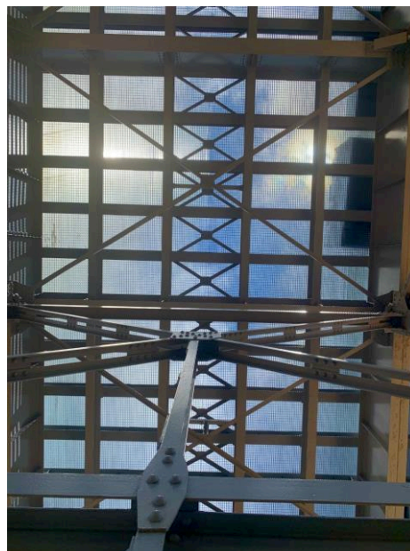
Figura 11 – Superfície de rolamento vista de baixo
