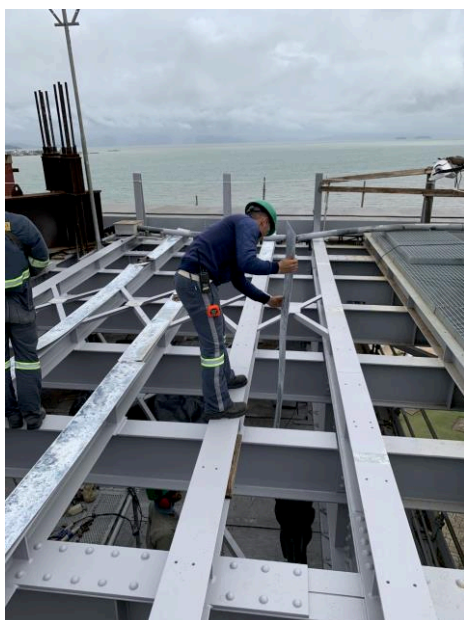
Figura 60 - Passagem da chapa galvanizada para a plataforma de trabalho inferior.
