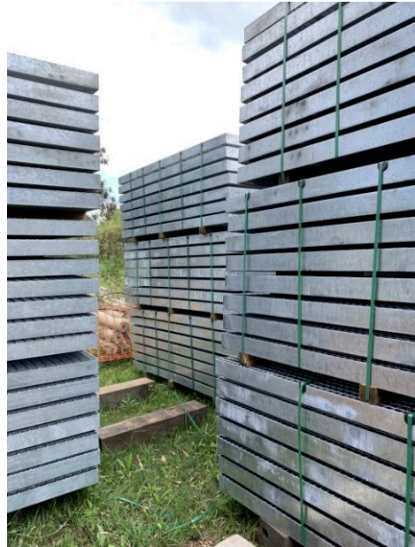
Figura 45 - Gradis armazenados no canteiro do Saco dos Limões.
