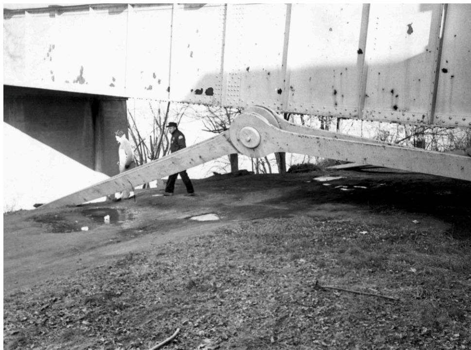
Figura 2: Barra de Olhal deteriorada Silver Bridge - Ohio
