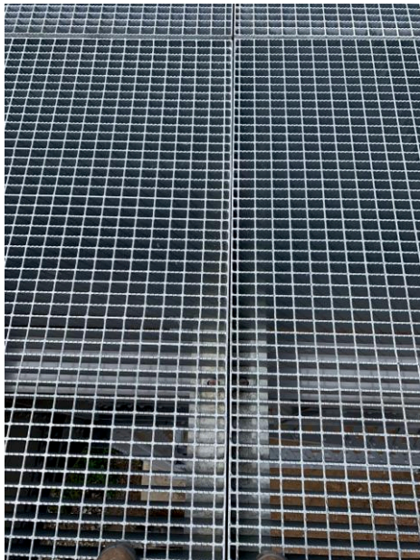
Figura 32 – Gradis justapostos sem a presença da junta simples de dilatação.
