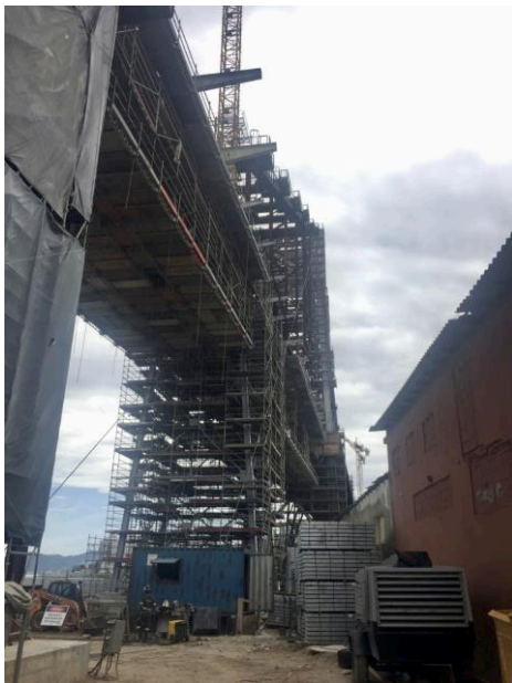
Figura 46 - Gradis armazenados no canteiro do continente.
