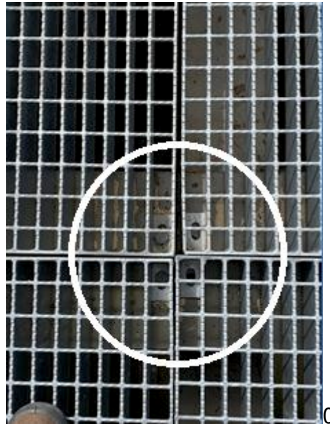
Figura 26 – Detalhe da extensão das paredes externas do gradil para fixação das placas nas transversinas
