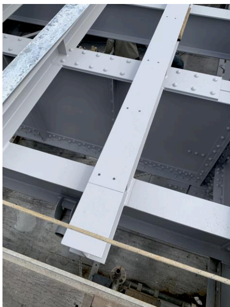
Figura 58 - Transversina auxiliar com furos prontos e pintura feita.
