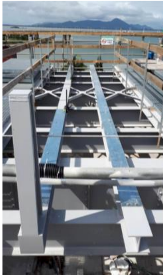
Figura 23 – Chapas galvanizadas instaladas sobre as transversinas auxiliares
