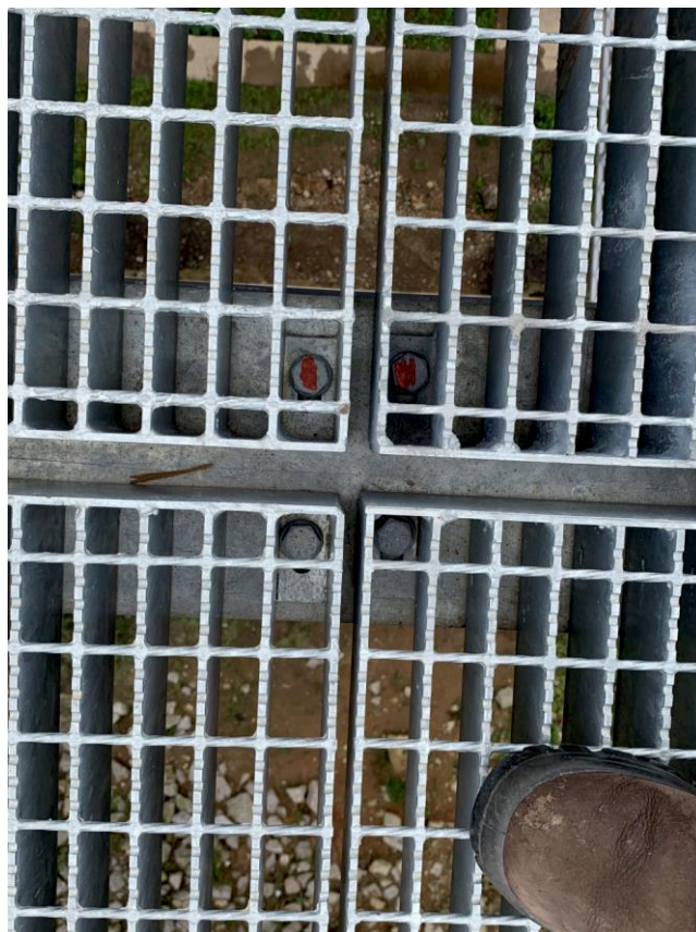
Figura 68 – Parafusos torqueados e não torqueados
