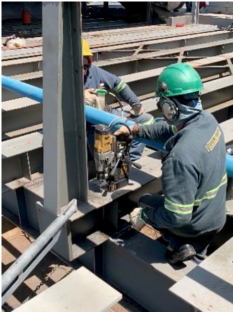
Figura 54 – Furação das transversinas auxiliares
