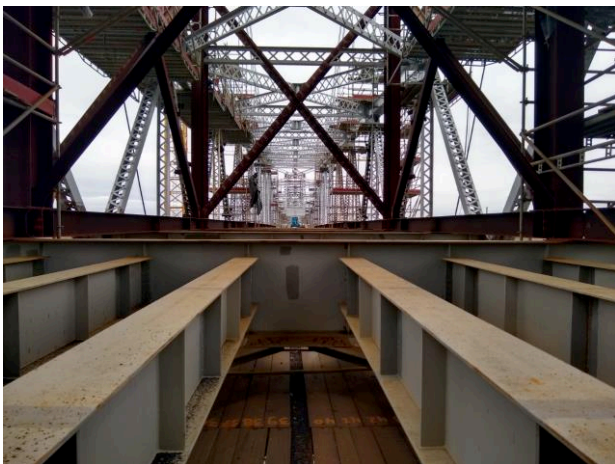
Figura 35 – Longarinas e Transversinas estruturais recuperadas.
