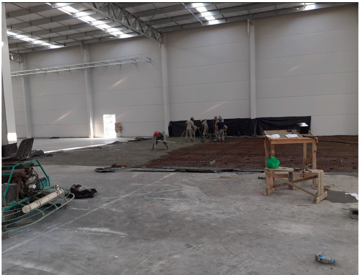
Figura 36 – Concretagem do último pano de piso.
