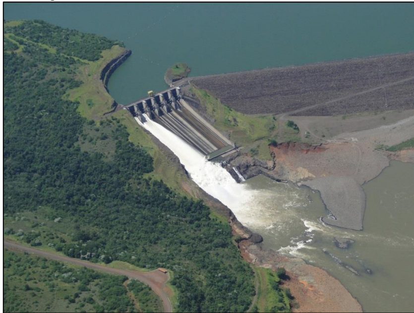
Figura 13 – Vertedouro da Usina de Hidrelétrica de Itá
