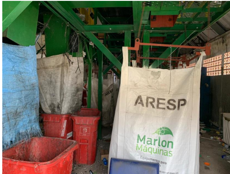
Figura 24: Bags suspensas para condicionamento de material.
