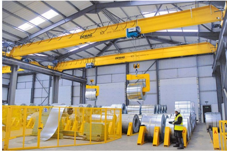
Figura 12 - Estrutura de ponte rolante.
