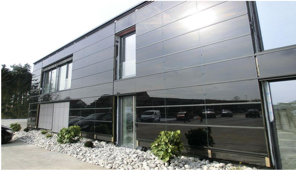
Figura 11 - Aplicação de módulos de CdTe em fachada residencial.
