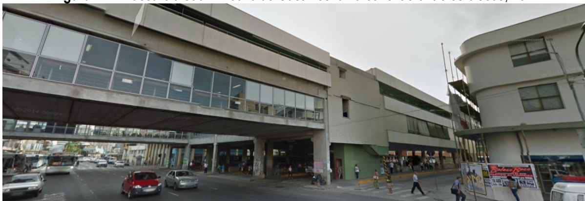
Figura 22 – Passarela sob Av. Júlio de Castilhos faz a conexão entre os blocos, 2014.
