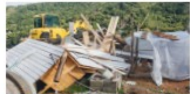
Trabalho foi realizado em dois terrenos no Alto da Caieira
