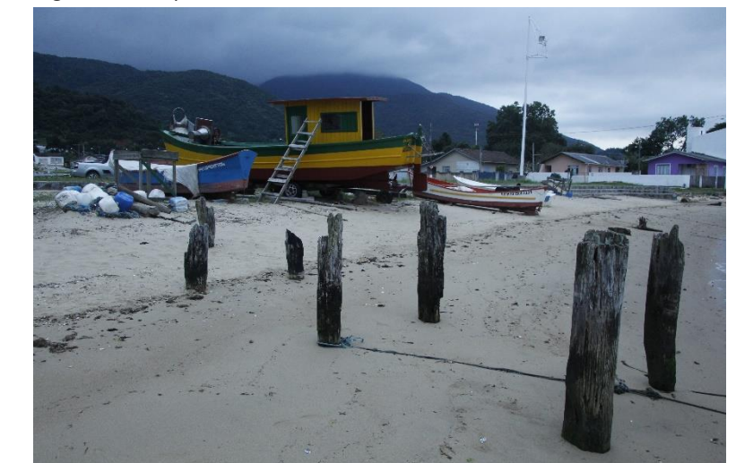
Figura 61: Ruínas do trapiche
