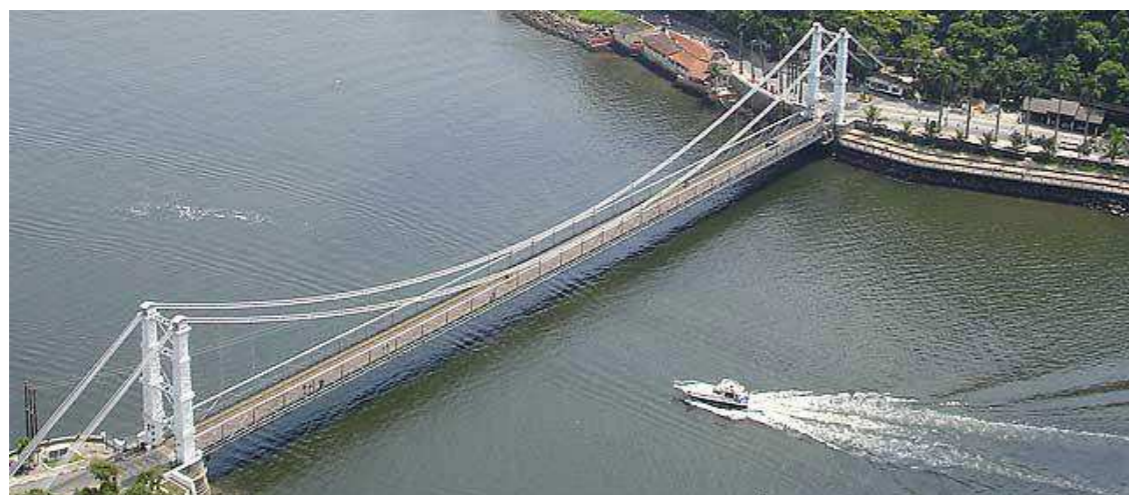
Vista aérea da Ponte São Vicente. Fonte: cidadespaulistas.com.br
