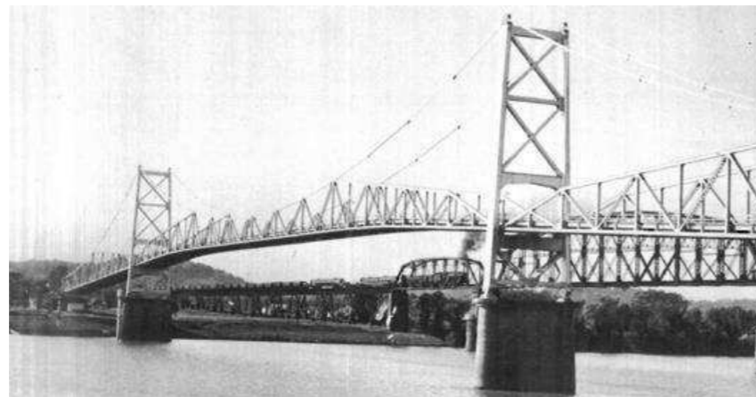
Silver Bridge. Fonte: wvpublic.org
