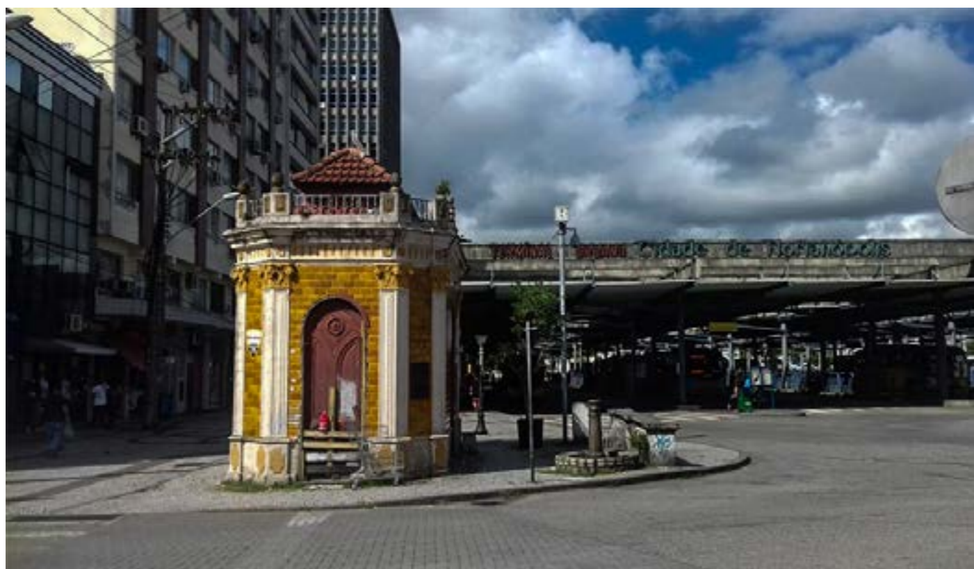
Em primeiro plano a antiga casa de elevação de água, nota-se a presença da antiga balastrada que marcava o limite entre a malha urbana e o mar, em segundo plano o Terminal urbano Cidade de Florianópolis Fonte: Acervo Pessoal
