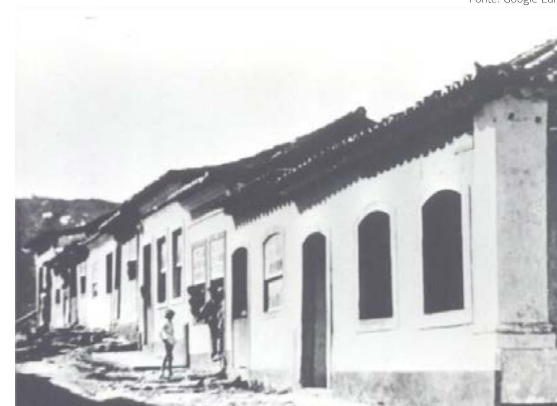
Casas do tipo porta janela na Rua Nunes Machado em 1931, hoje no local está o prédio do Ministério da Fazenda. Fonte: Acervo Casa da Memória
