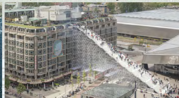
Escada temporária, 2016, Rotterdam, Holanda.
