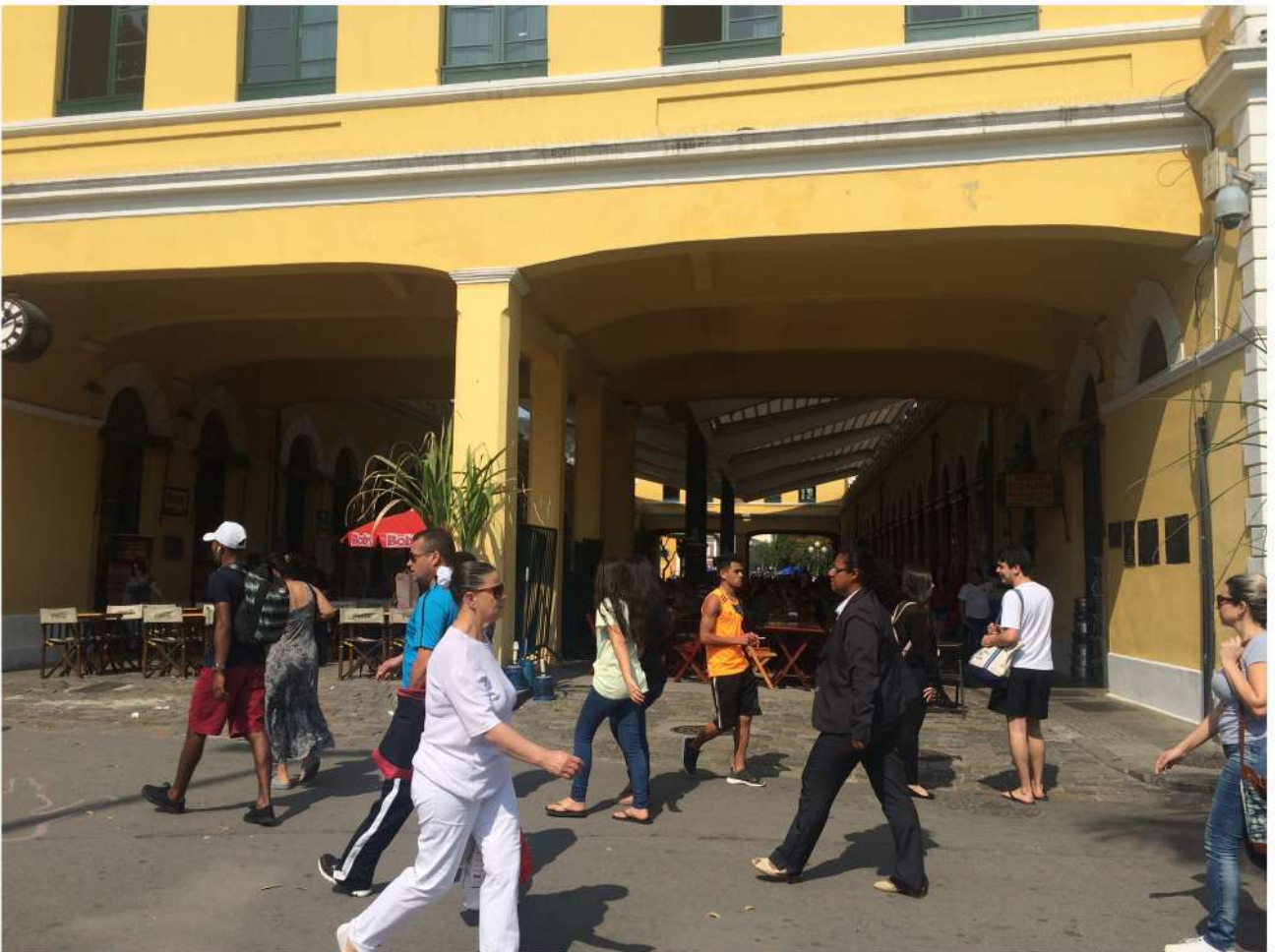
Entorno do Mercado Público 2018 Fachada Oeste
