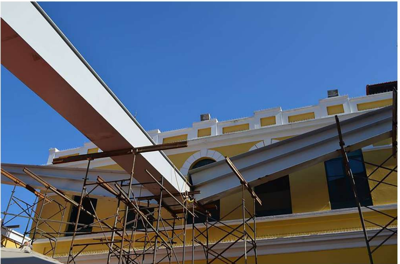
Construção cobertura vão central 2016
