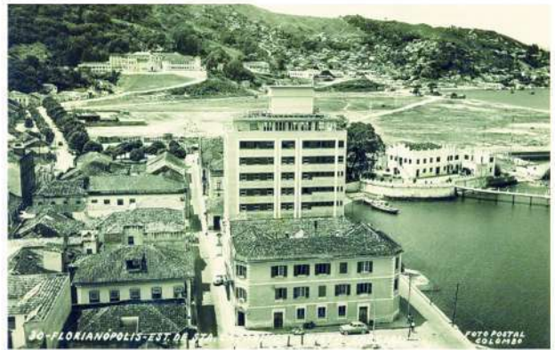
Primeiro aterro construído em Florianópolis. Foto: Casa da Memória de Florianópolis
