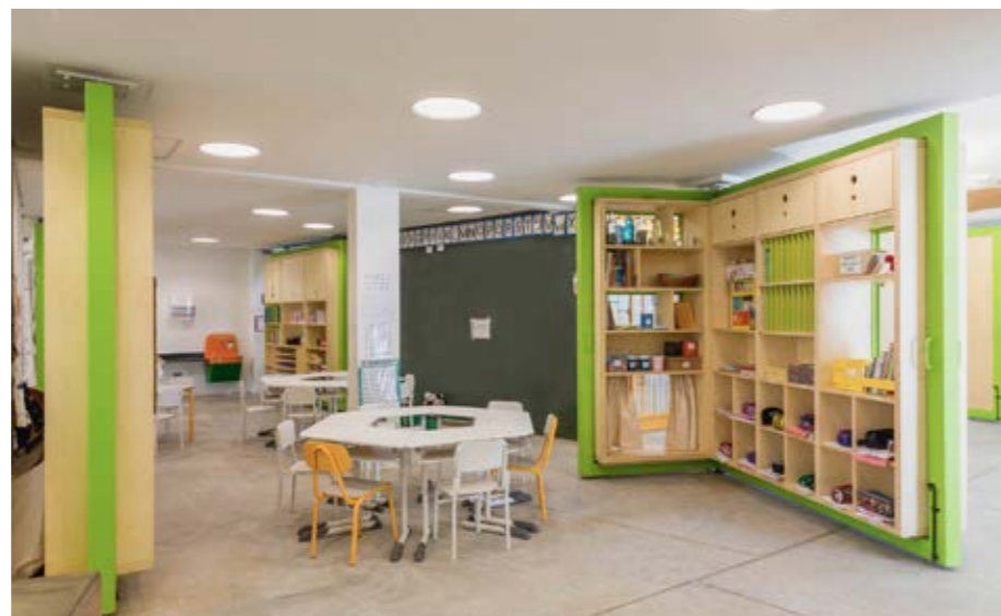
Figura 65. Divisórias móveis das salas de aula integrada ao mobiliário funcional que permite diversas configurações de layout.
