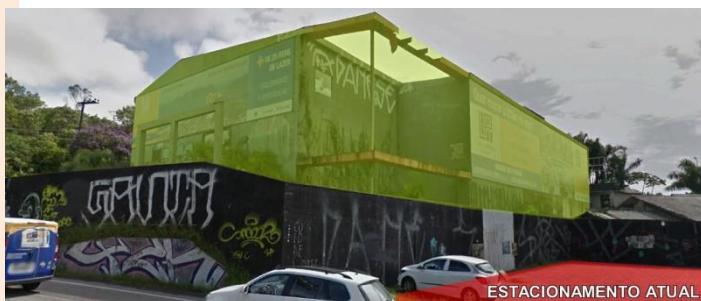
img 20. Edifício Existente.
