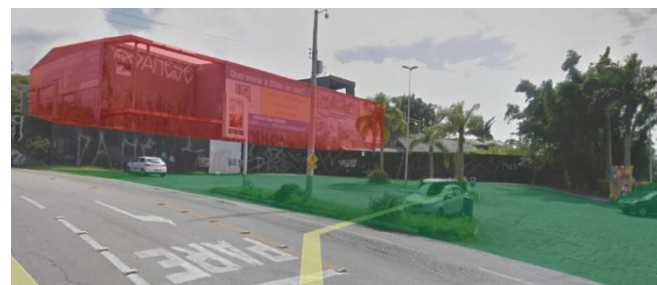
img 21. Edifício e Estacionamento Existente.
