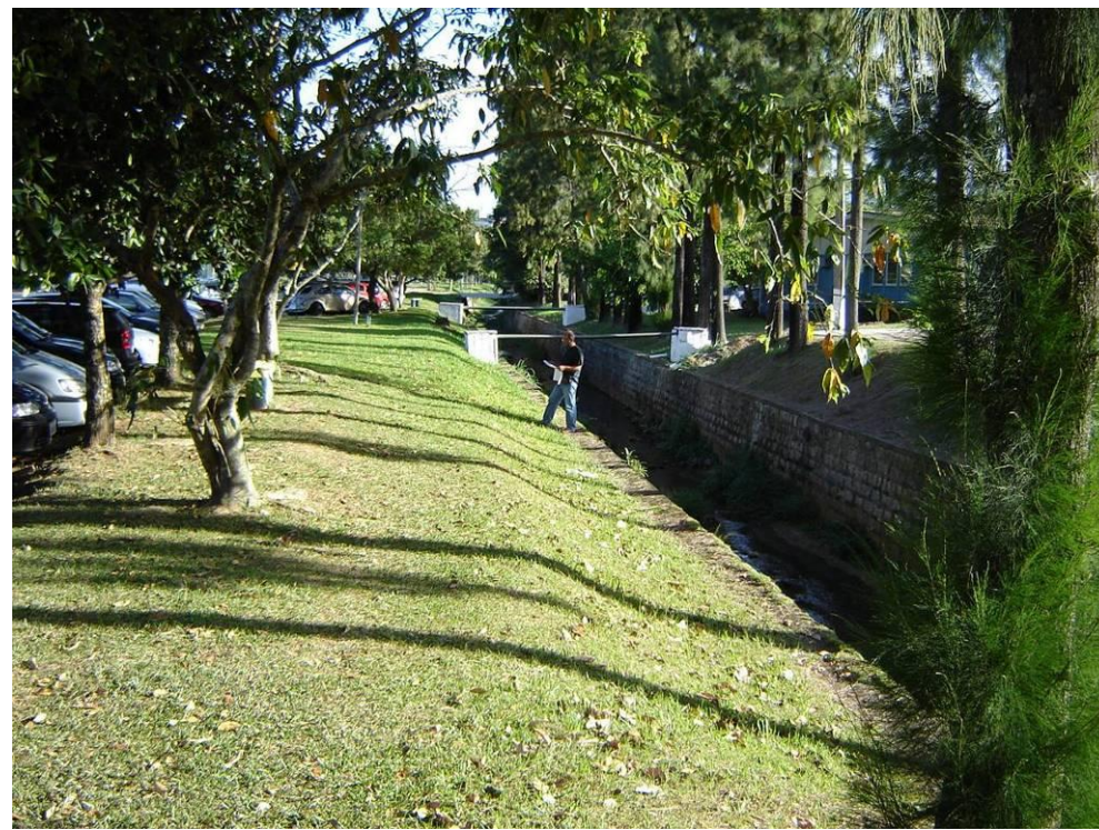
FOTOS 8- CANAIS DE DRENAGEM COM RECOMPOSIÇÃO DE VEGETAÇÃO CILIAR
