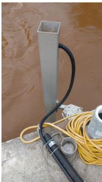
Figura 47 – Instalação da sonda.
